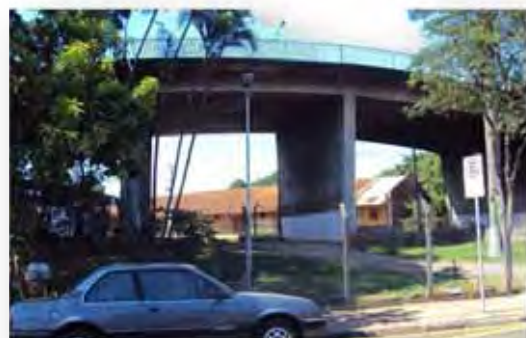
Vista da passagem em nível para o pontilhão , dez 2010
