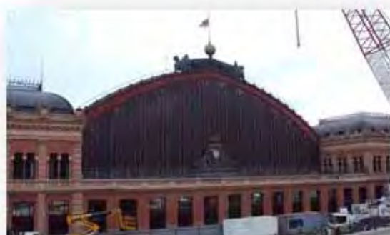
Estação Atocha, Madri - Espanha
