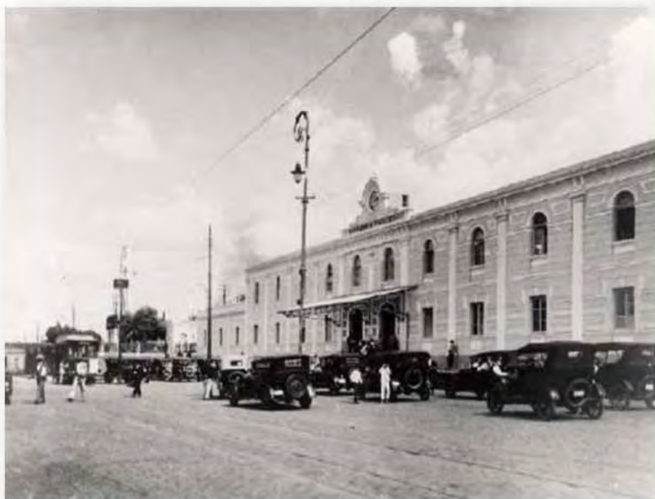
A estação em 1918, já reformada.
