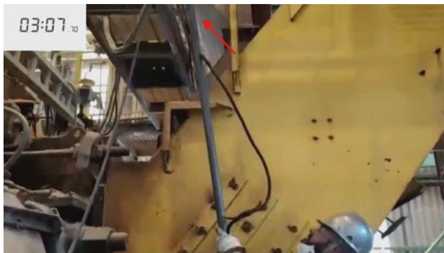
Figura 17 – Preparação do cabo positivo para içamento ao piso 2
