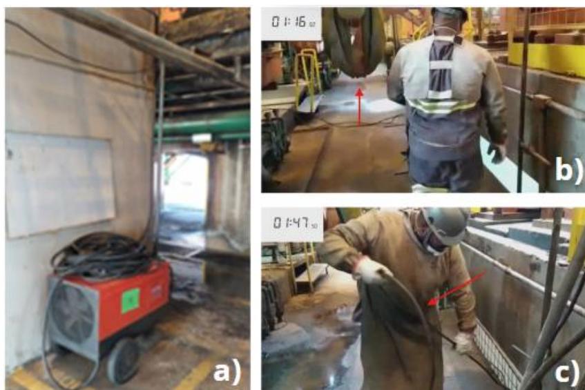
Figura 20 – Causas de desperdício e riscos da situação 1 (a) Cabo negativo armazenado e enrolado sobre máquina de solda (telhado de proteção fixado na parede) (b) risco de batidas contra ACIPs (c) risco ergonômico
