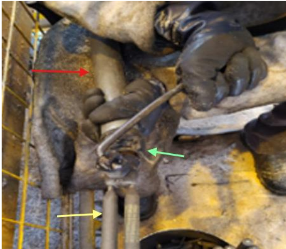
Figura 18 – Bastão isolante com alicate e eletrodo instalados
