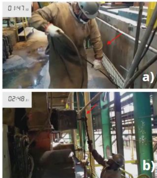
Figura 16 – (a) Içamento do cabo negativo (b) cabo engatado ao rolo que será soldado
