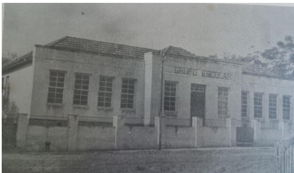
Figura 10 – Prédio do Grupo Escolar “João Breiks”, Distrito de Varpa.
