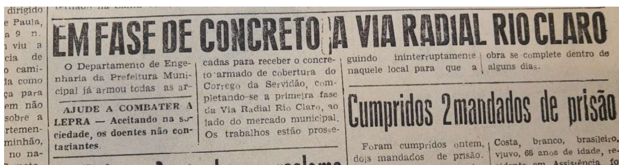
Figura 10 - Imagem do Jornal Cidade de Rio Claro noticiando as obras de canalização do córrego da Servidão em 23 de fevereiro de 1962
