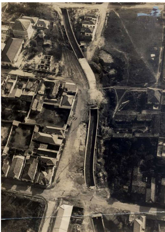
Figura 9 - Foto aérea das obras de canalização do córrego da Servidão. Sem data
