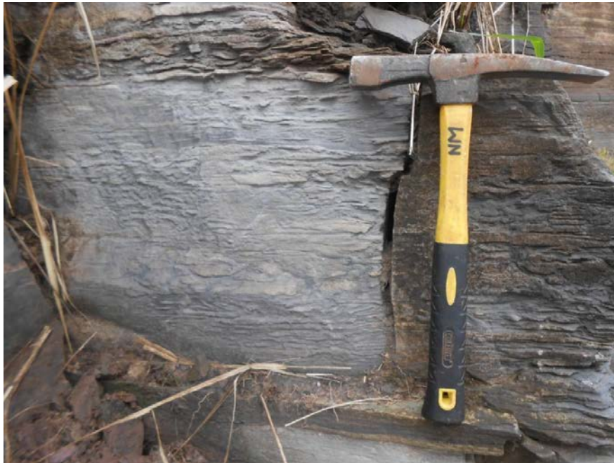
Figura 40: Junta subvertical deformando em siltito da Formação Rio do Rastro com abertura de aproximadamente 1 cm. Ponto 5.
