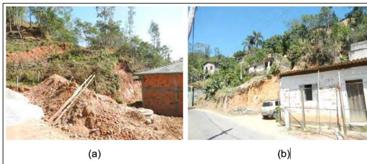
Figura 12 - Fotografias dos setores de risco no Bairro dos Freitas
