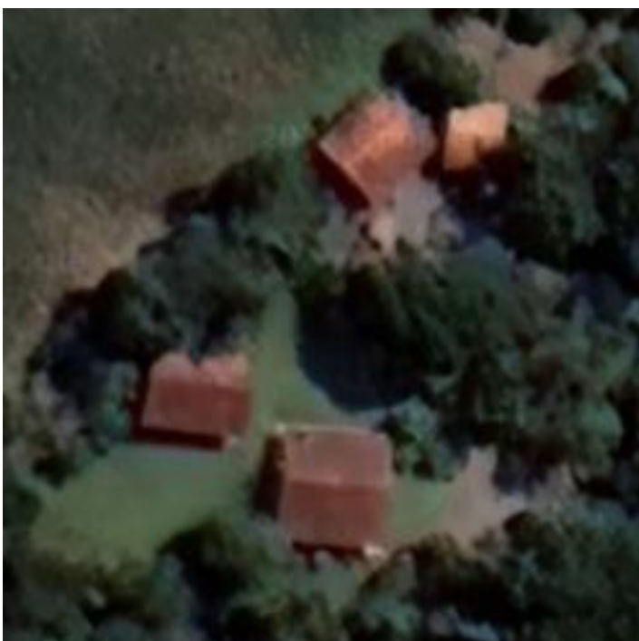
Figura 19 - Área dos telhados para implantação do sistema.
