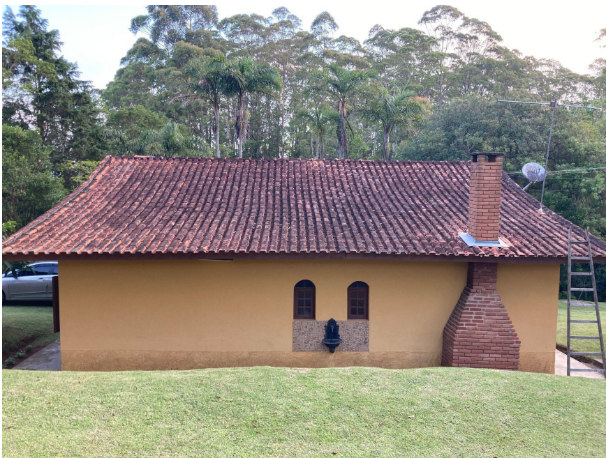
Figura 21 - Face norte do telhado.
