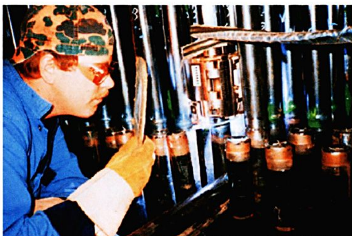
Figura 2.17 – Emprego de cabeçote orbital compacto em substituição à soldagem manual (cortesia Arc Machines)
