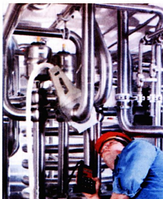
Figura 2.20 – Soldagem orbital por fusão em tubulação de aço inox
