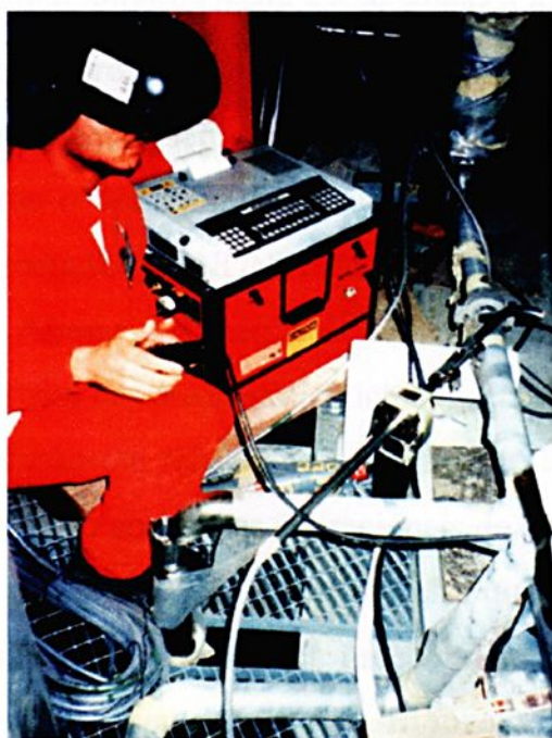
Figura 2.18 – Soldagem orbital em tubos de pequenas dimensões (por fusão)
