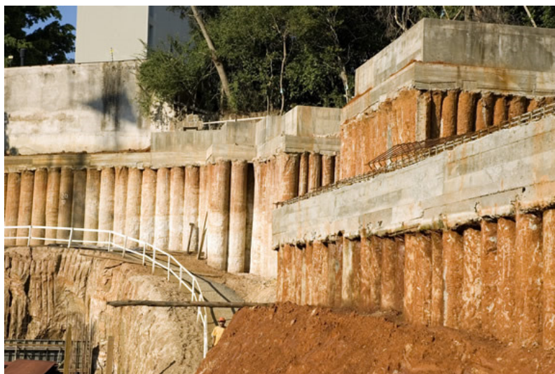
Figura 3: Estacas hélice justapostas (SERKI, 2016).
