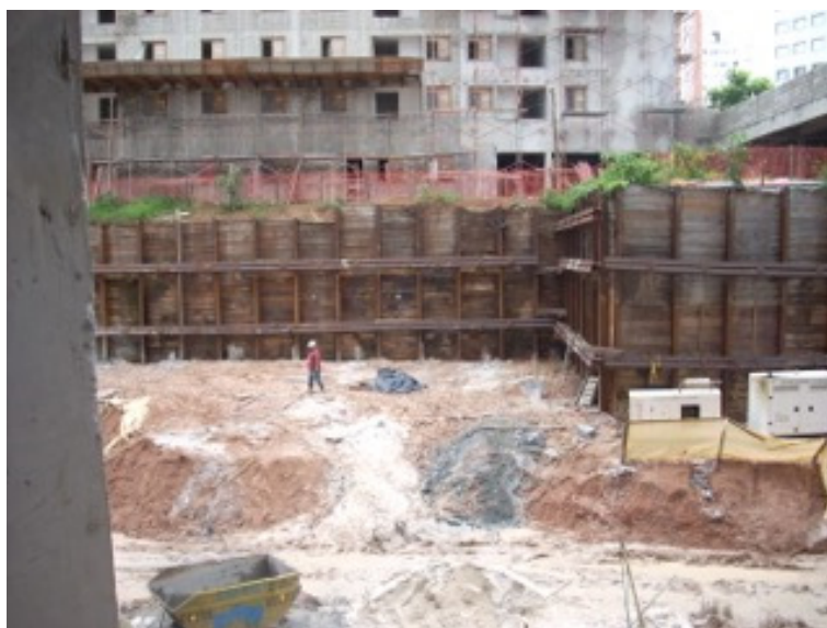
Figura 79: Cortina atirantada executada em Curitiba (imagem cedida pelo projetista).
