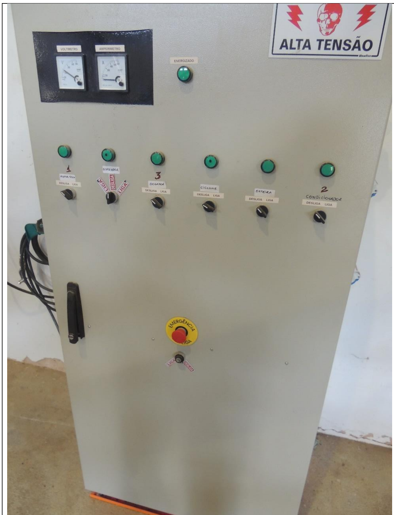
Figura 13. Painel de comando elétrico da peletizadora.
