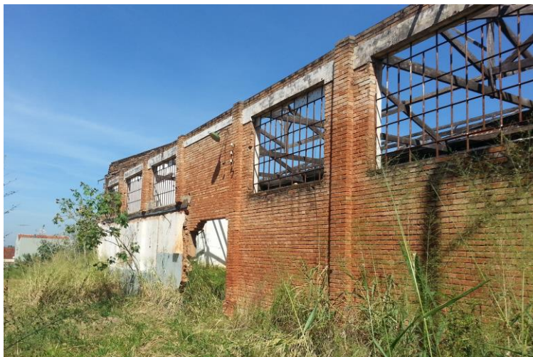
Figura 13: Estrutura do telhado aparente
