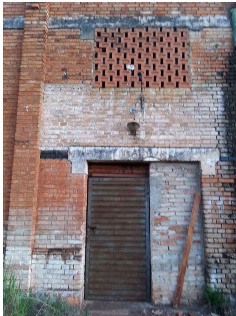
Figura 23: Parte da parede construída posteriormente para comportar a porta.
