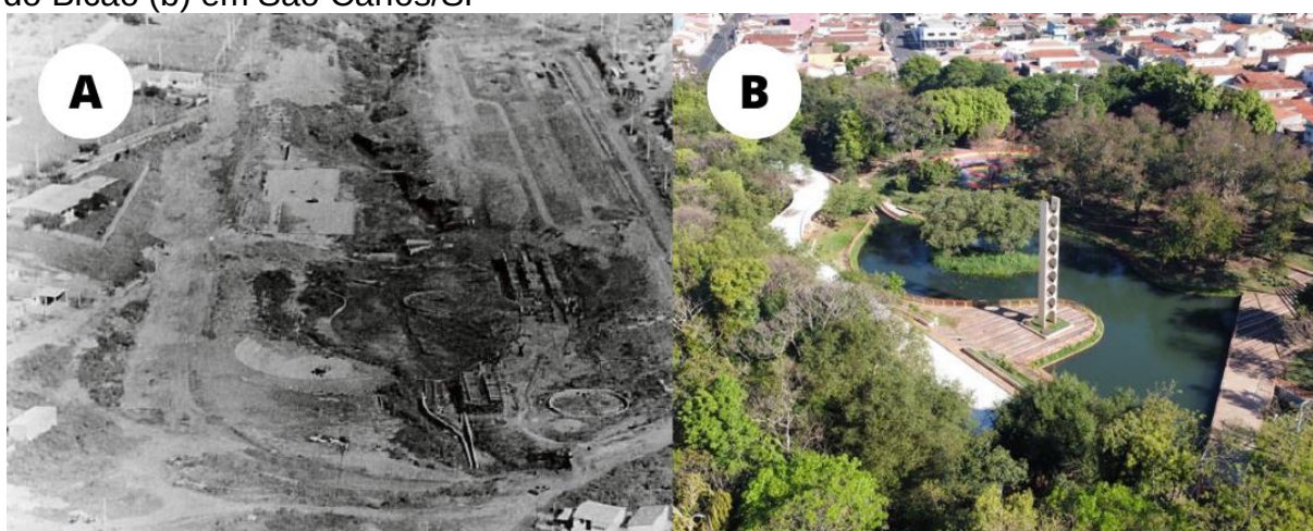
Figura 7. Início das obras para recuperação do processo erosivo (a) e atual Parque do Bicão (b) em São Carlos/SP
