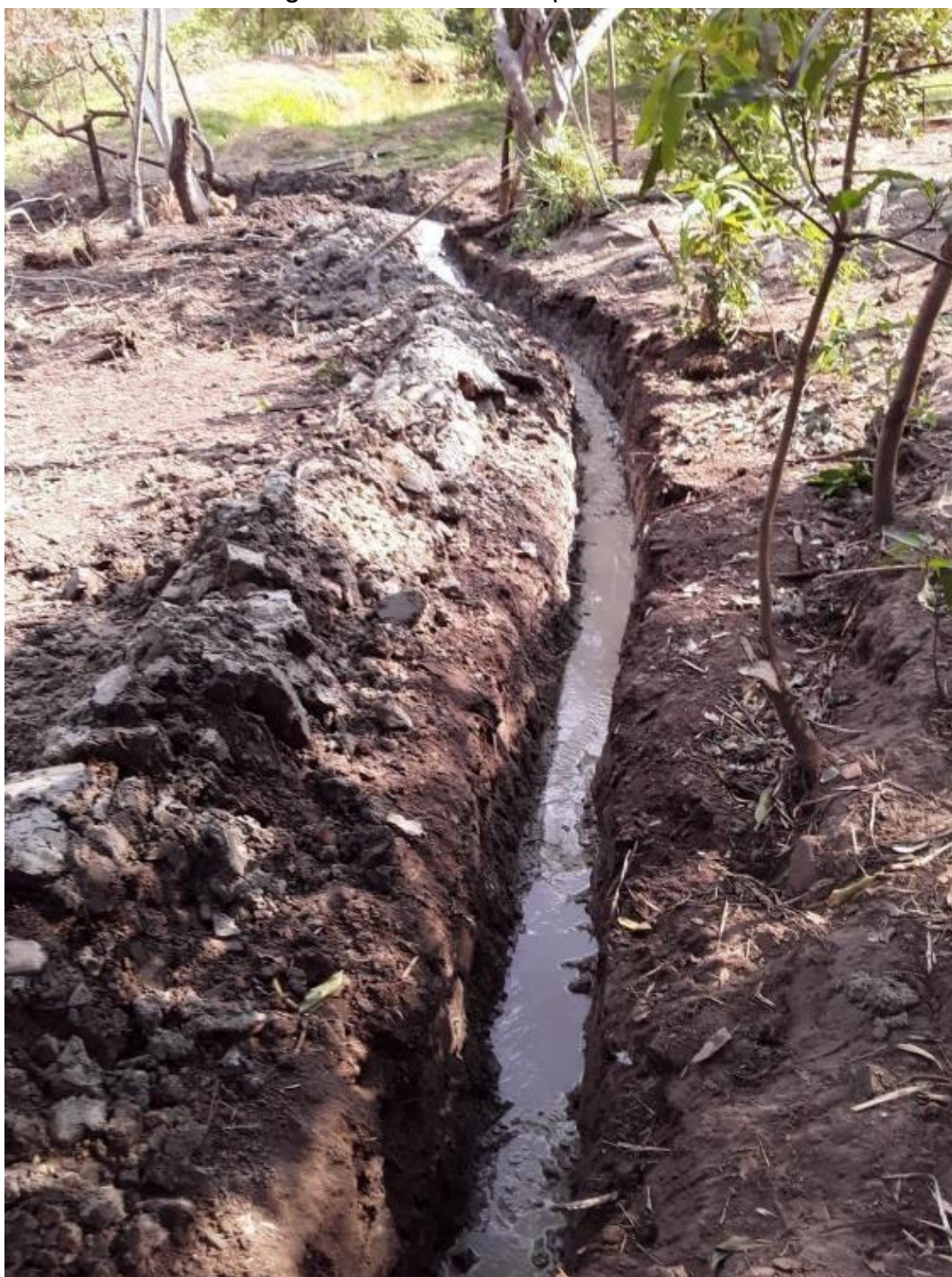
Figura 26 - Corte e Limpeza da área
