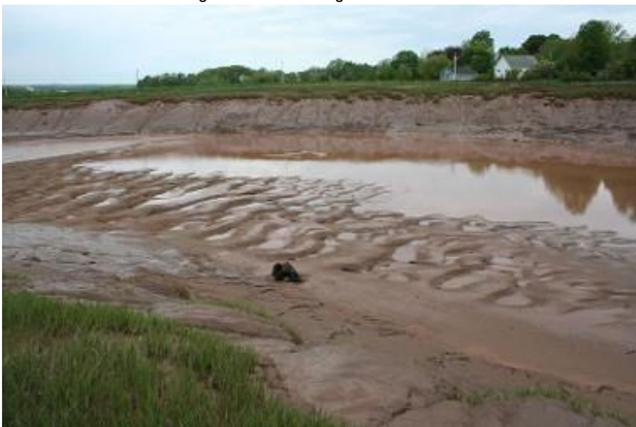
Figura 31- Canal D'água Assoreado
