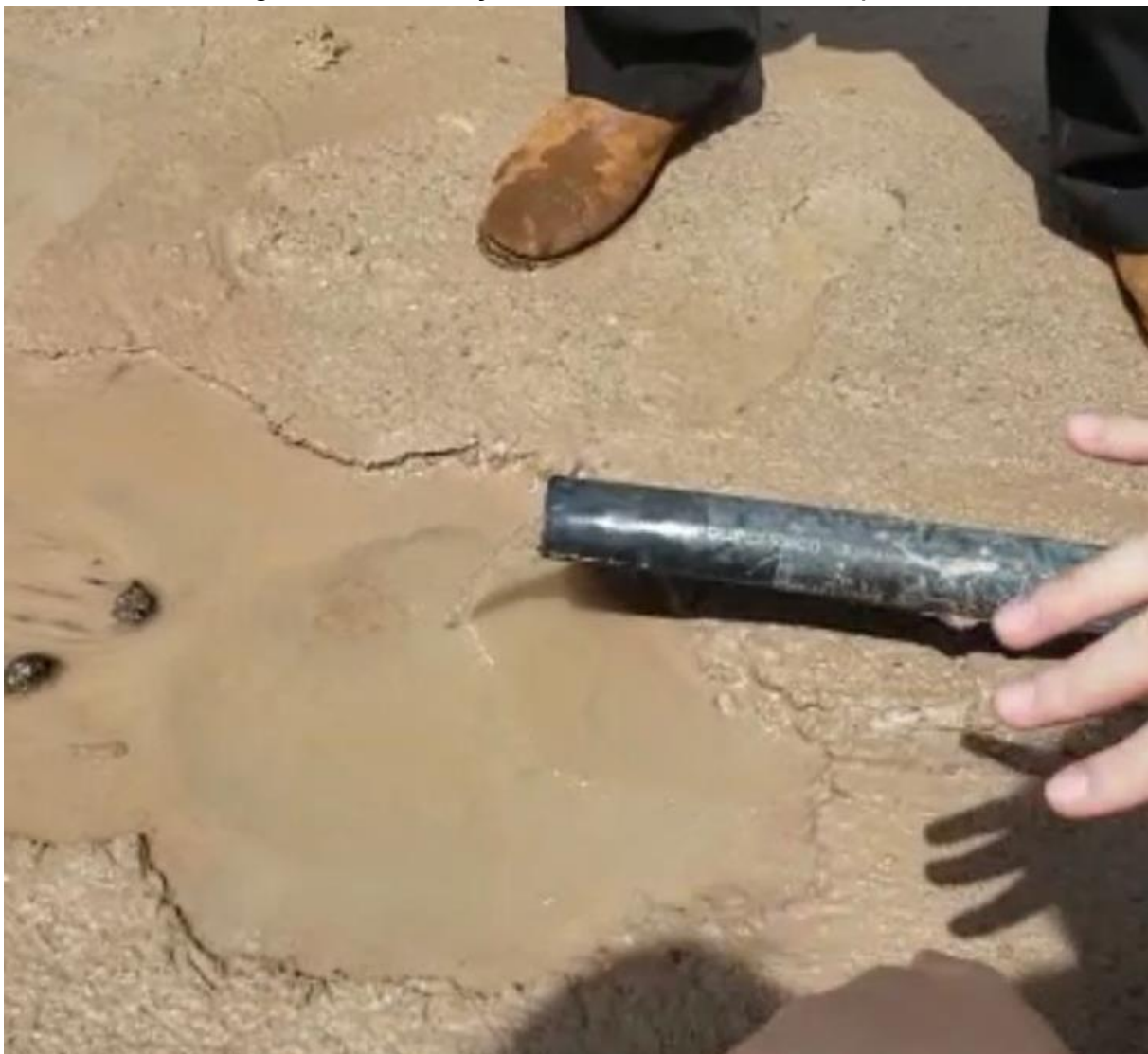
Figura 27 - Tubulação final alimentando uma represa
