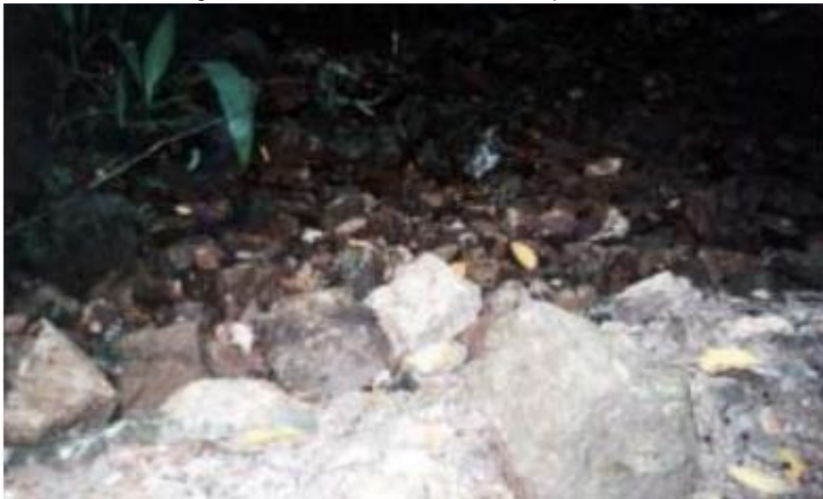
Figura 29 - Obra Concluída Revestida por Pedras
