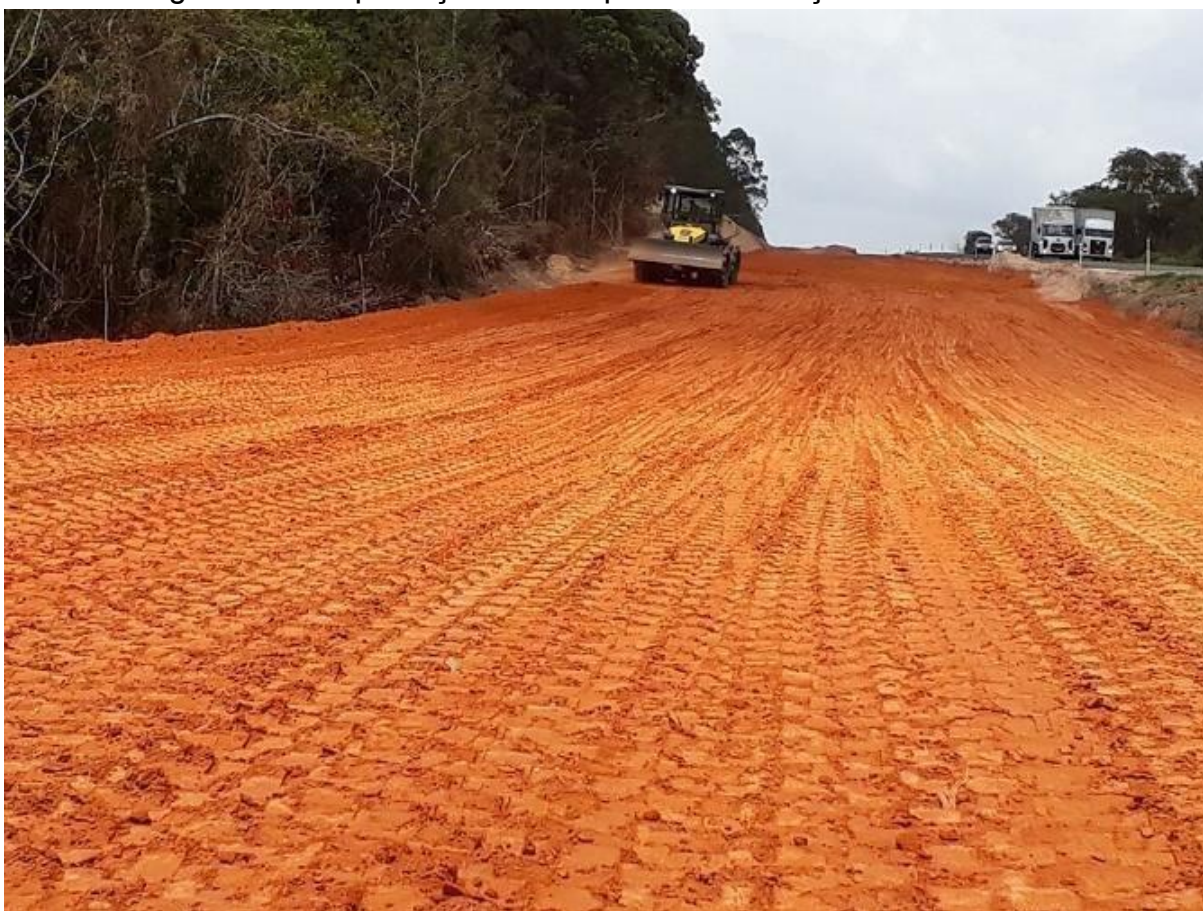
Figura 7 - Compactação do solo para a construção de uma rodovia
