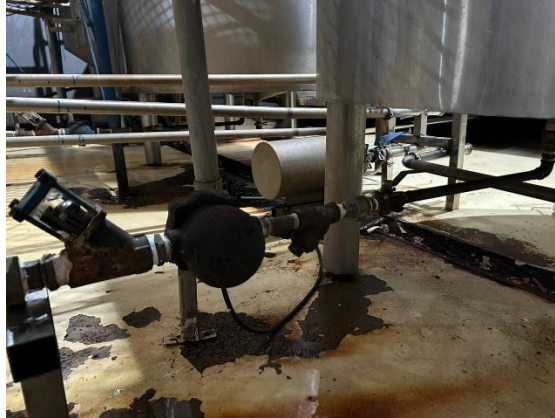
Figura 4: Filtro, retentor e purgador inline .
