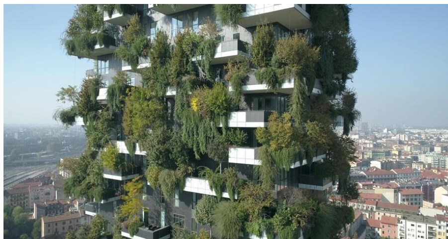
Figura 5 – Edifício Bosco Verticale, primeira floresta vertical do mundo.
