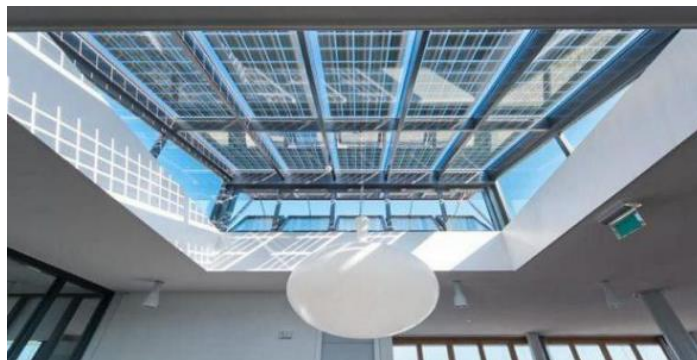
Figura 9 - Exemplo de aplicação de painéis fotovoltaicos transparentes
