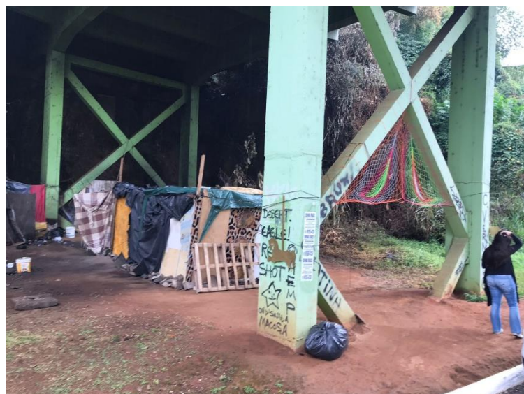
Figura 11 - Barraca montada embaixo de viaduto
