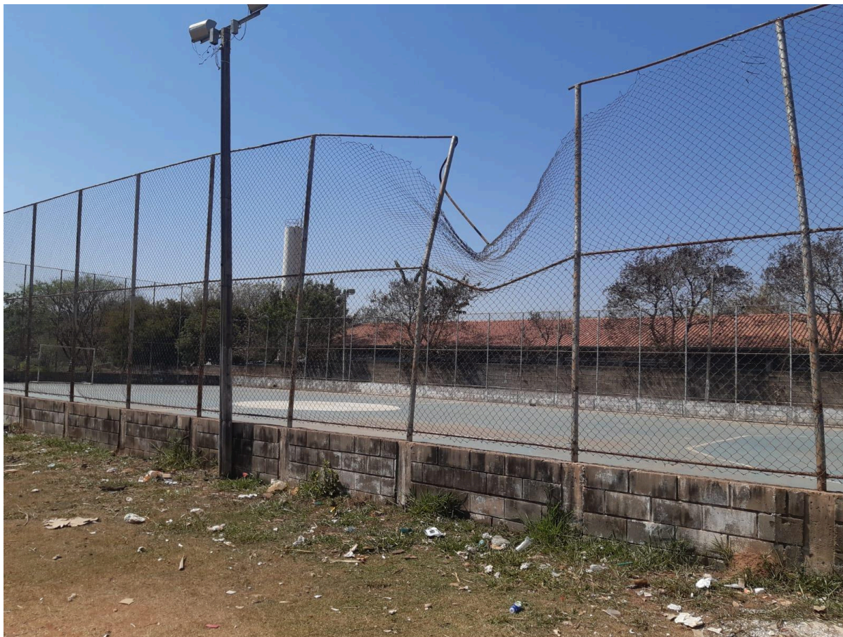
Figura 4 - Quadra poliesportiva danificada ao lado da Escola Municipal Celeste Calil (2024).
