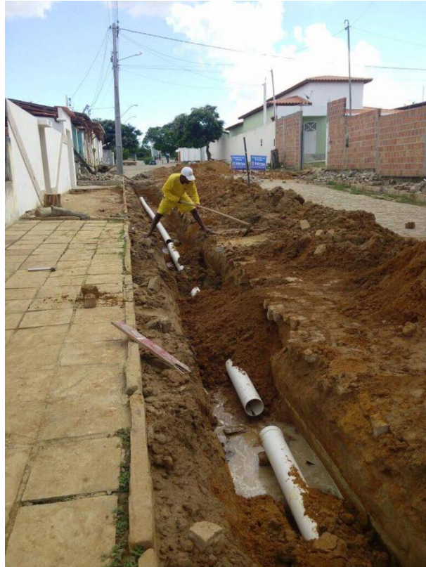
Figura 7 – Instalação de uma rede de esgoto.
