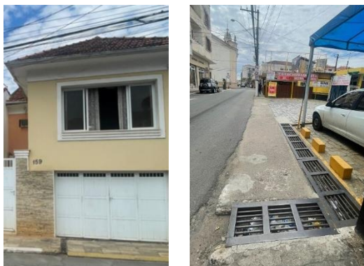
Figura 47 - Presença de grelhas nas faces de quadras 501C e 503C respectivamente.
