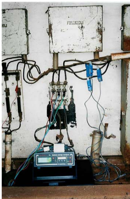
FIGURA 6. Medição do consumo de energia elétrica do motor indução trifásico de 25 CV do sistema de irrigação.
