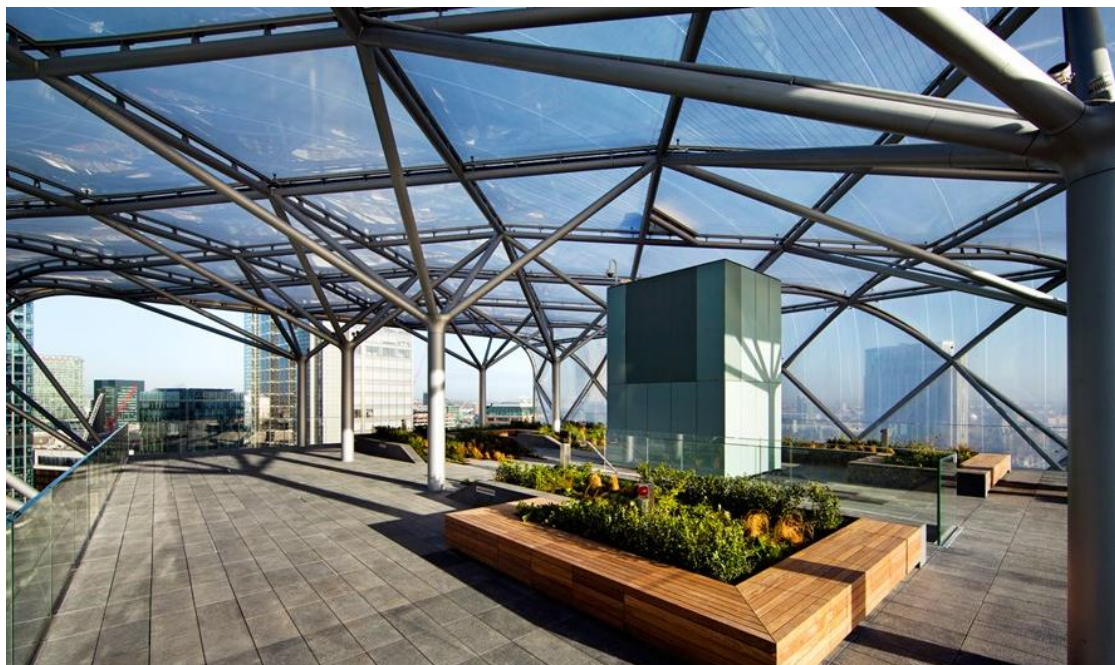
Figura 12 - Estrutura do telhado do prédio 6 Bevis Marks, impressa em 3D.
