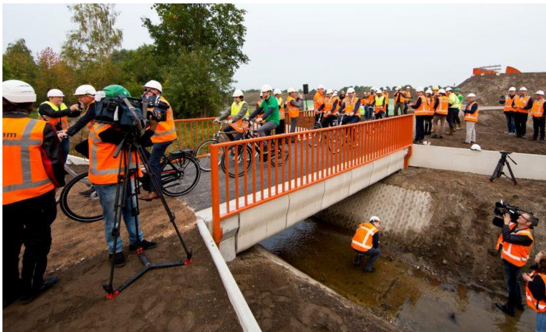
Figura 10 - Ponte para ciclistas impressa 3D pela BAM e TU/e.
