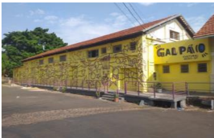
Figura 3 – Fachada do Ponto de Cultura Galpão Cultural de Assis
