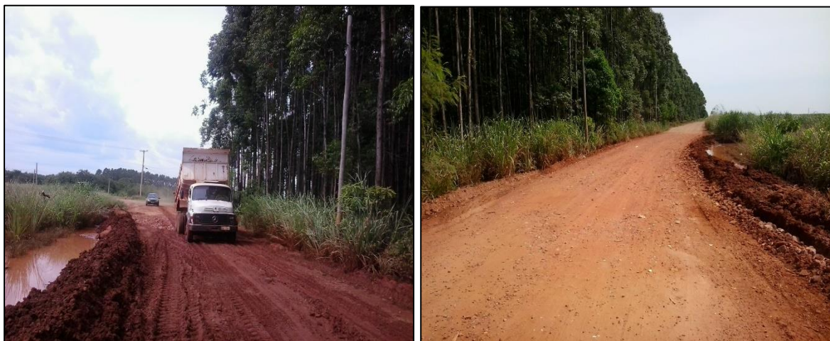
Figura 45: Situação da via LEP 335 “anterior” e “posterior” a regularização com RCC reciclado
