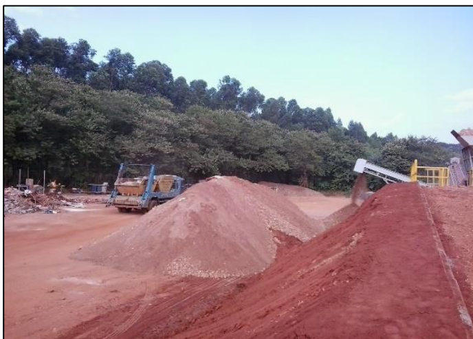
Figura 41: Armazenamento de RCC com maior teor de “finos”
