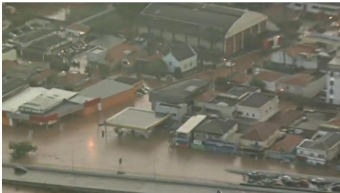
Figura 5: Inundação no bairro do Rochdale, após o transbordamento do córrego do Braço Morto
