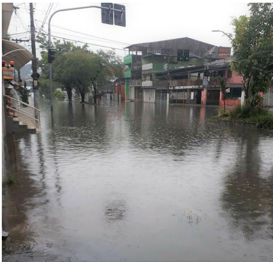
Figura 6: Alagamentos no Rochdale em março de 2018
