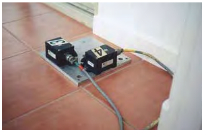
Figura 6.20 – Sensores utilizados nos testes do Heritage Court Tower
