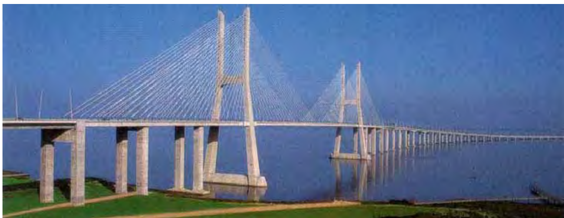
Figura 1.4 - Ponte Vasco da Gama, Lisboa, Portugal.
