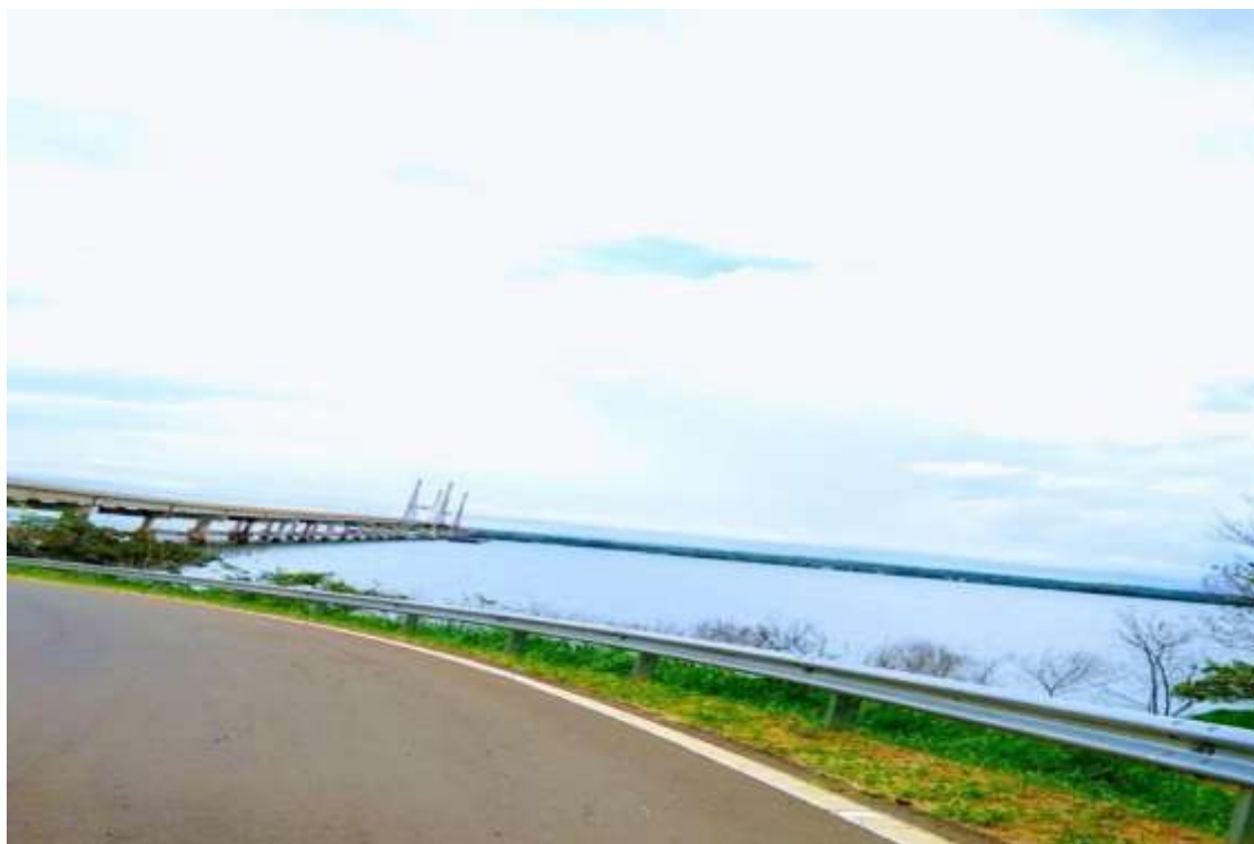
Figura 1-Ponte Mário Covas no Município de Paulicéia
