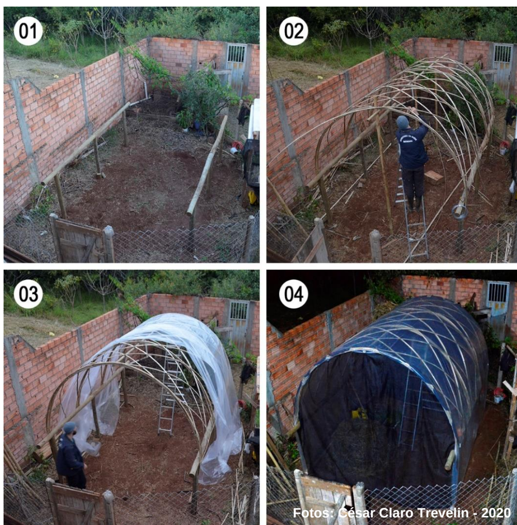
01. Base de eucalipto; 02. Montagem dos arcos de bambu; 03. Fixação da cobertura plástica; 04. Estufa pronta.
