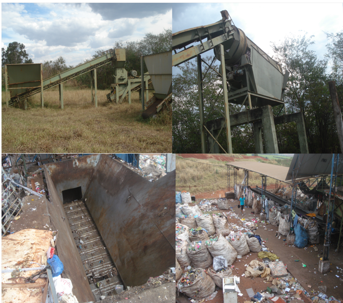
Figura 31. Registro fotográfico do maquinário de reciclagem abandonado no lixão de Ibitinga/SP.
