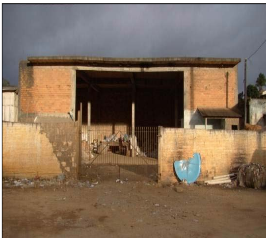
Fotografia 87 - Barracão para a separação dos materiais recicláveis. Fonte: Do autor (2012).
