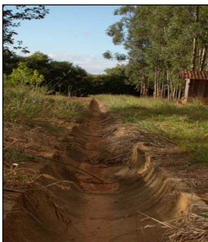
Fotografia 13 – Canaleta Lateral Fonte: Do autor (2012).
