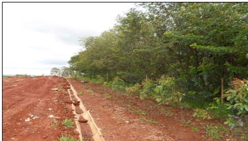
Fotografia 20 - Vista do aterro de Barão de Antonina e do canal de drenagem concretado. Fonte: Do autor (2012).
