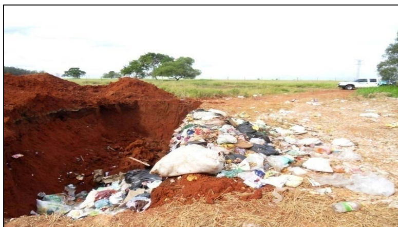
Fotografia 25 - Vala em uso para o aterro de resíduos sólidos urbanos. Fonte: Do autor (2012).
