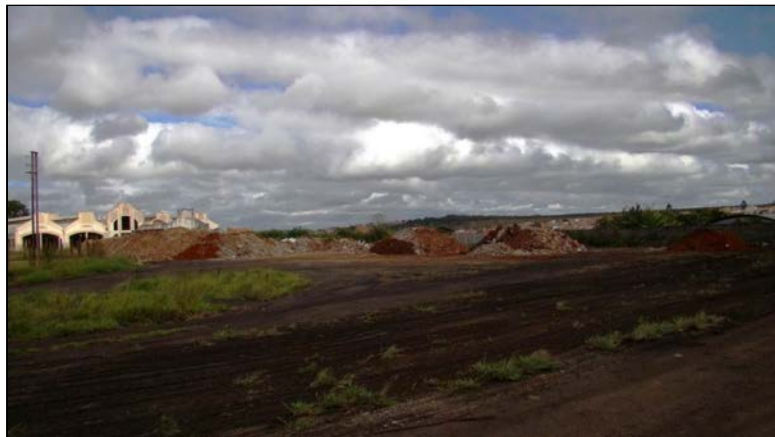
Fotografia 63 - Vista geral do local de acondicionamento de RCC. Fonte: Do autor (2012).
