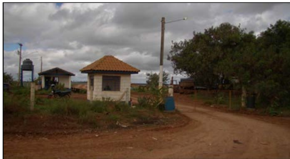
Fotografia 64 - Guarita do aterro sanitário de Itapetininga, São Paulo. Fonte: Do autor (2012).
