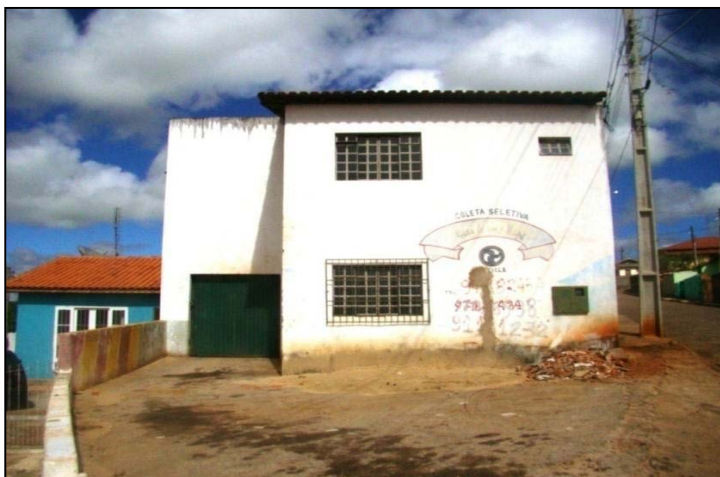
Fotografia 49 – Ex-sede da associação de catadores no município de Itaberá. Fonte: Do autor (2012).
