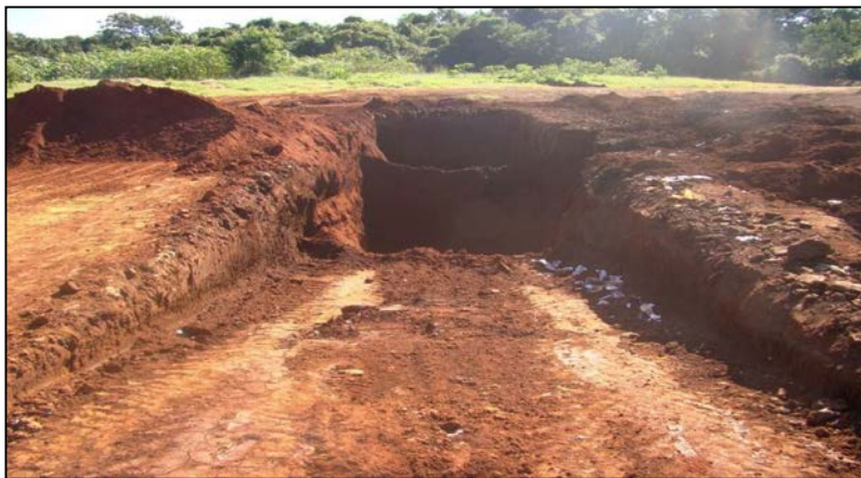
Fotografia 39 - Vala em uso no aterro. Fonte: Do autor (2012).
