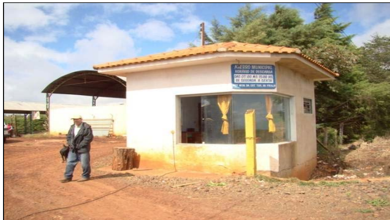
Fotografia 80 - Guarita na entrada do aterro sanitário de Pirajú. Fonte: Do autor (2012).
