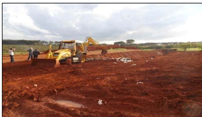
Fotografia 23 - Manejo mecânico de resíduos para aterro.
