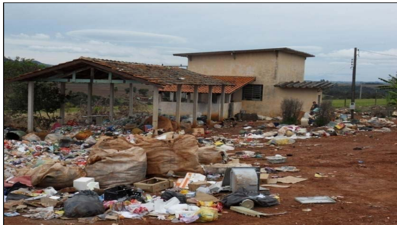
Fotografia 17 - Vista geral do galpão e da sede da associação de catadores de Barão de Antonina.
