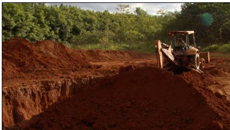
Fotografia 10 - Aterramento e compactação de resíduos no aterro municipal de Angatuba. Fonte: Do autor (2012).
