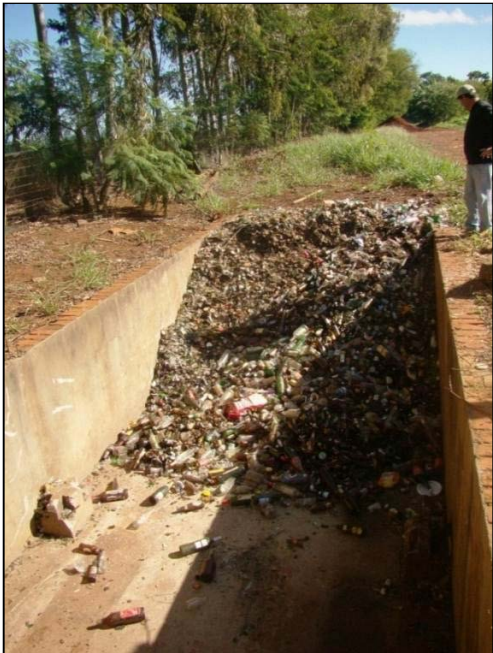
Fotografia 38 - Vala concretada para armazenar vidros. Fonte: Do autor (2012).
