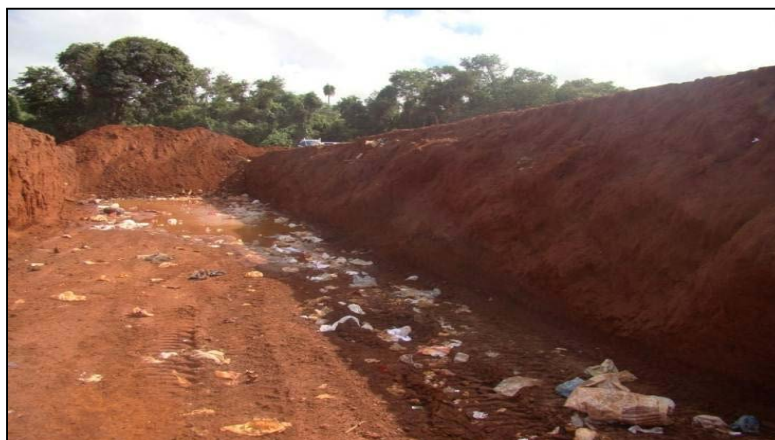
Fotografia 46 – Vala do aterro municipal de Itaberá. Fonte: Do autor (2012).
