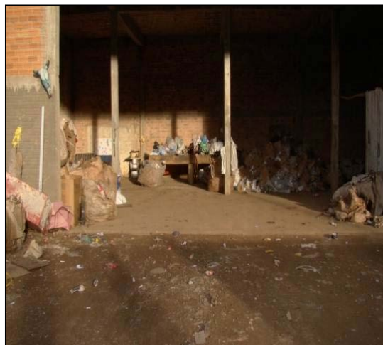
Fotografia 88 - Detalhe do interior do barracão. Fonte: Do autor (2012).
