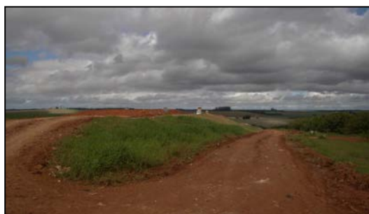
Fotografia 65 – Vista geral do aterro sanitário de Itapetininga. Fonte: Do autor (2012).
