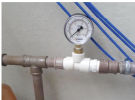
Figura 18 - Manômetro instalado
