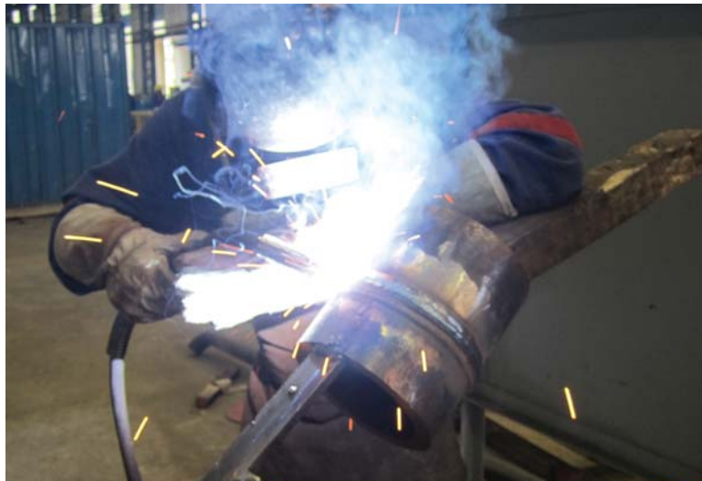
Figura 15 – Ilustração da soldagem do tubo de teste
