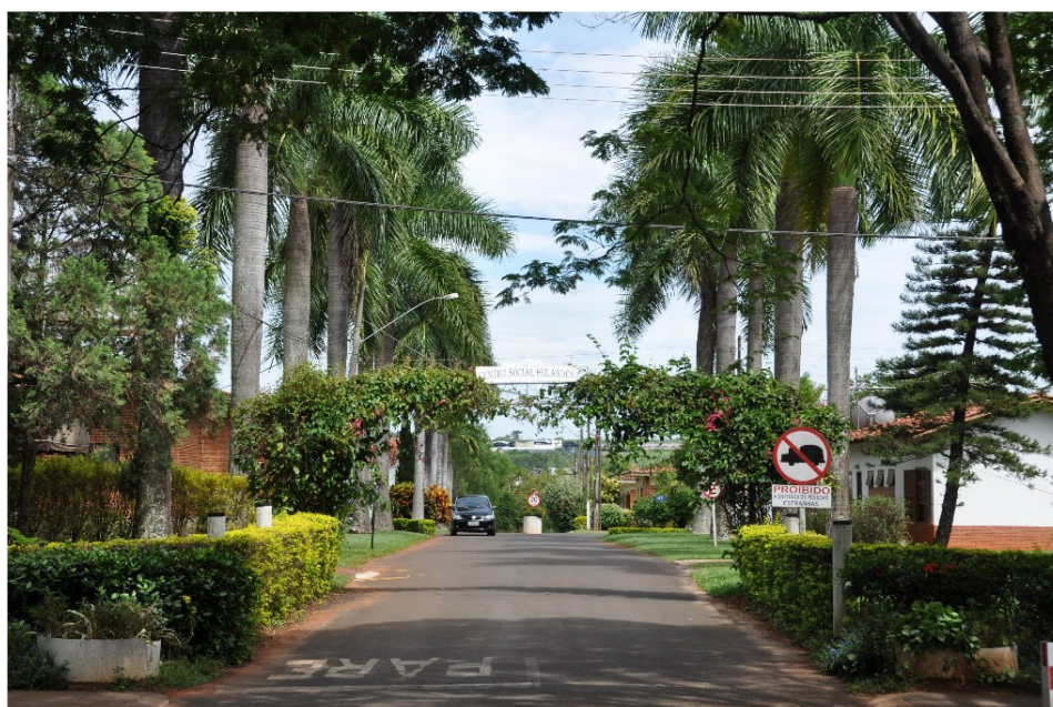
Figura 10 - Entrada da Casa de Repouso de Holambra
