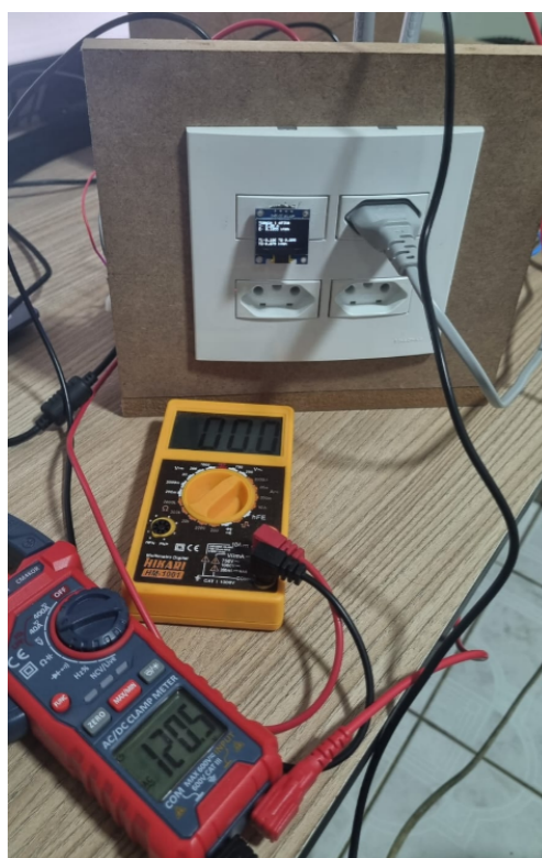
Figura 13- Verificação do intertravamento pelos multímetros
