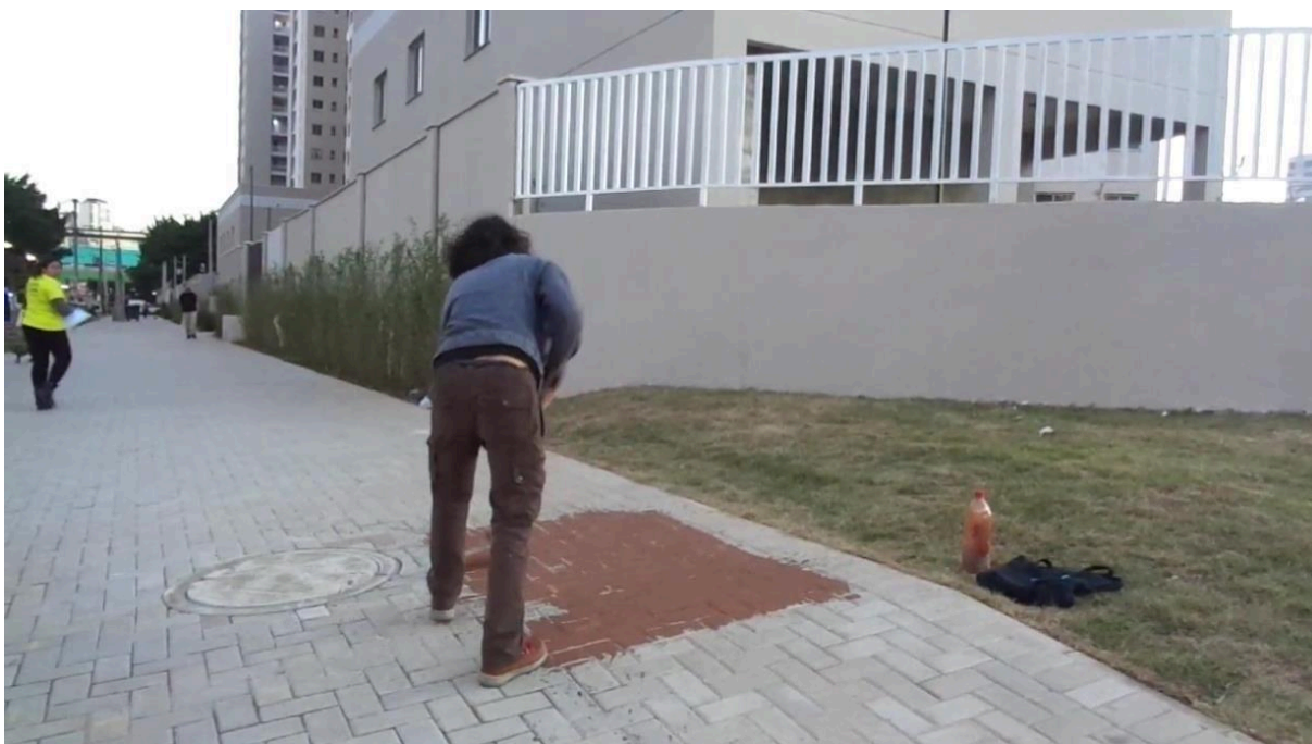
Figura 48 – Redistribuição de terra sobre calçada
