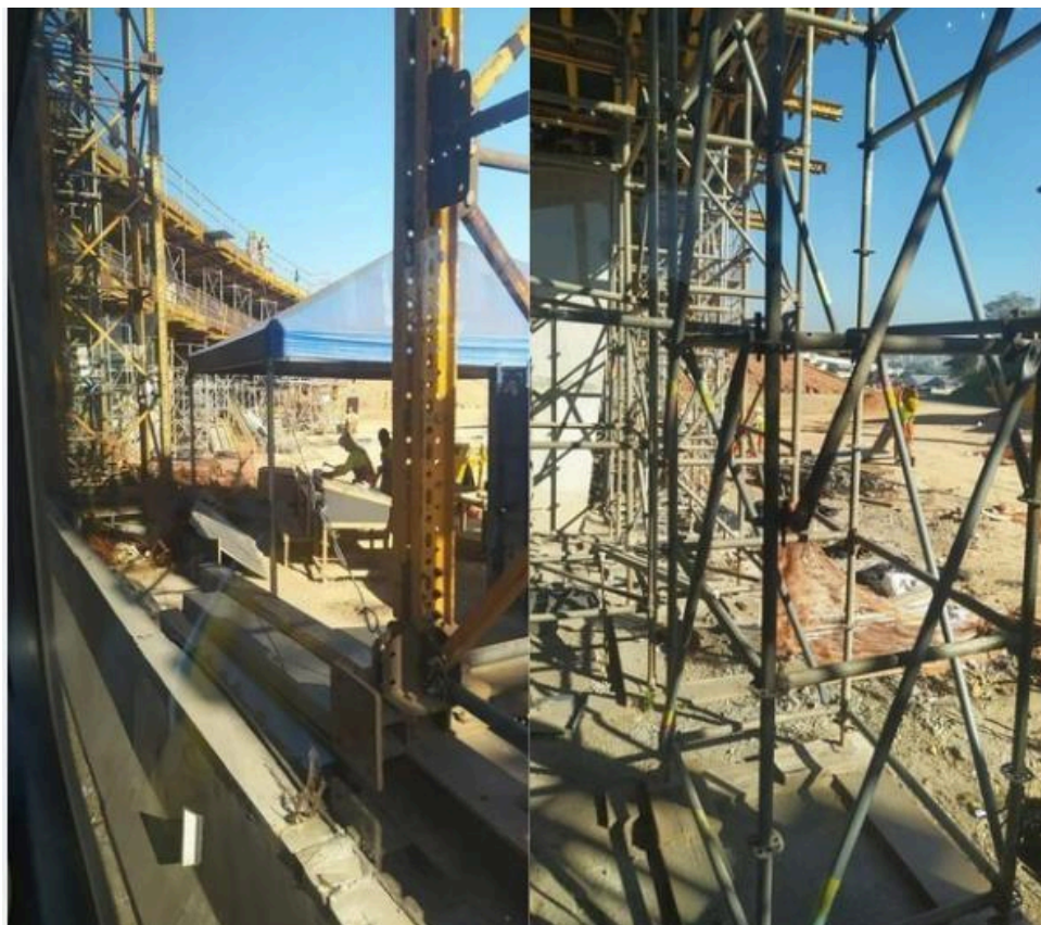
Figura 40 – Homens trabalhando nas obras da BR-116
