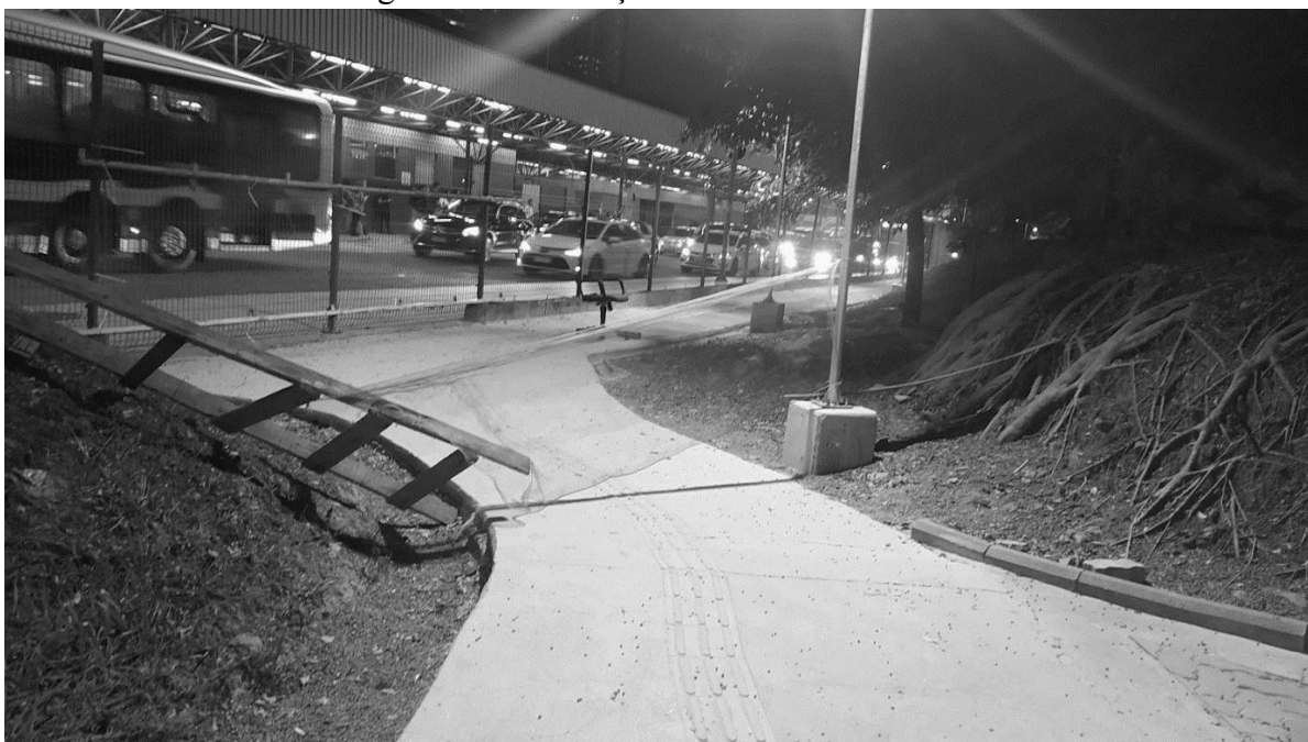
Figura 46 – Instalação de Pisos Táteis
