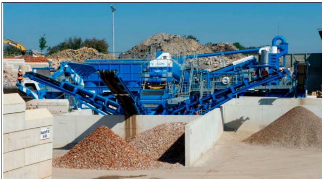
FIGURA 4 - USINA DE REAPROVEITAMENTO DE RCD EM OPERAÇÃO
