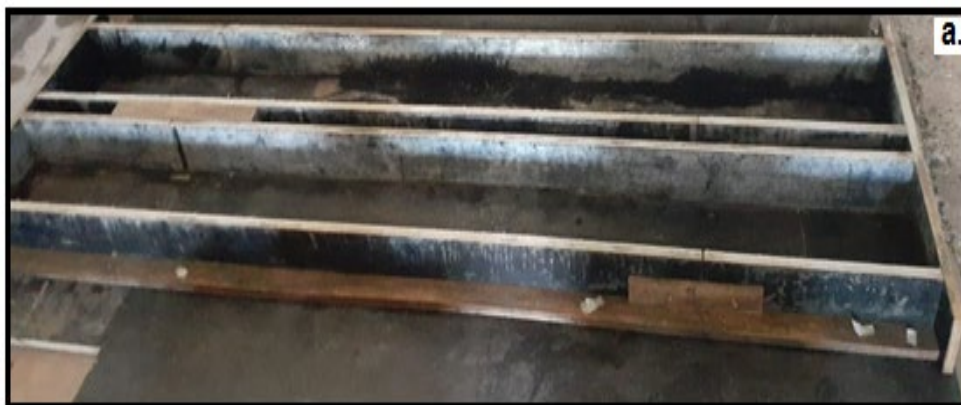
FIGURA 27 – PREPARAÇÃO DA FÔRMA PARA A MOLDAGEM DA VIGA.
