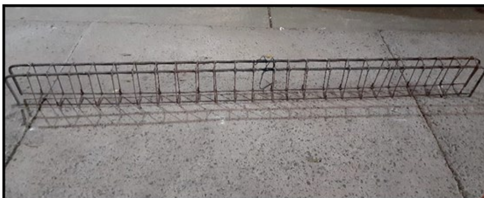
FIGURA 17 – ARMADURA PARA AS VIGAS.
