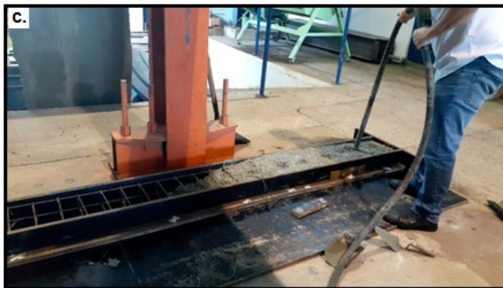
FIGURA 28- CONCRETAGEM DA VIGA VP.
