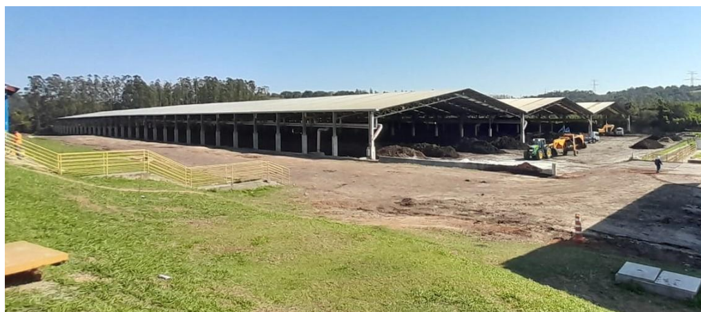
Figura 5 - Galpão de compostagem
