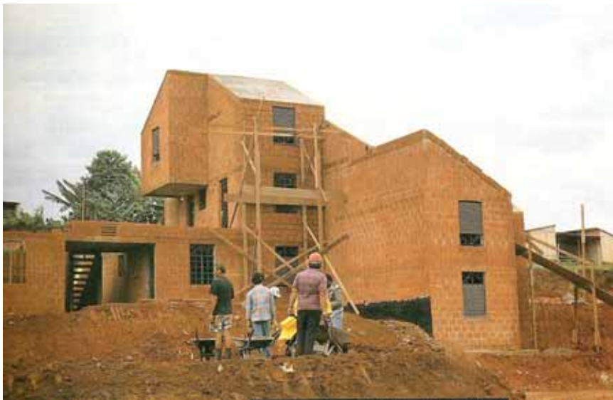
Figura 6 - Conjunto São Francisco, Foto da obra.
