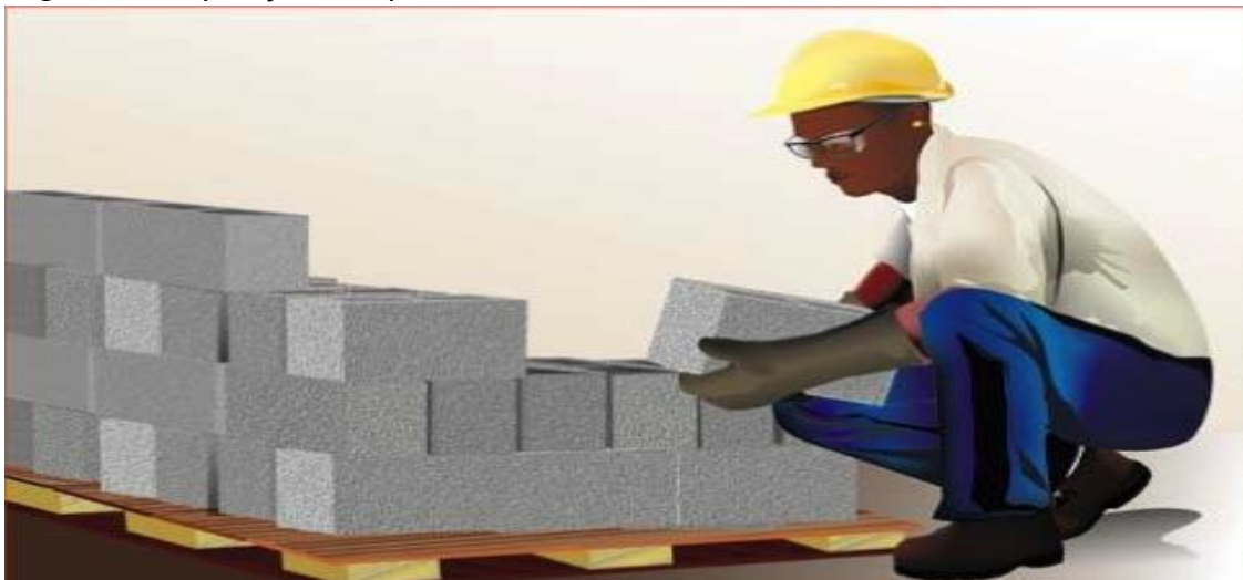
Figura 4: Disposição adequada de materiais num canteiro de obra
