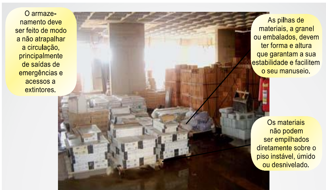
Figura 5: Disposição adequada de materiais em estoque num canteiro de obra
