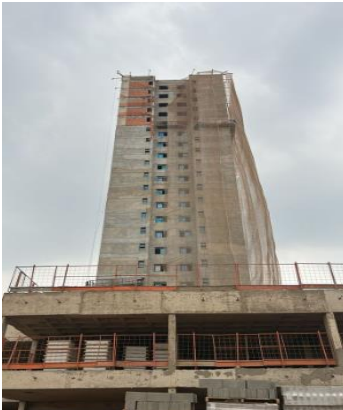
Figura 15: Canteiro de obra.
