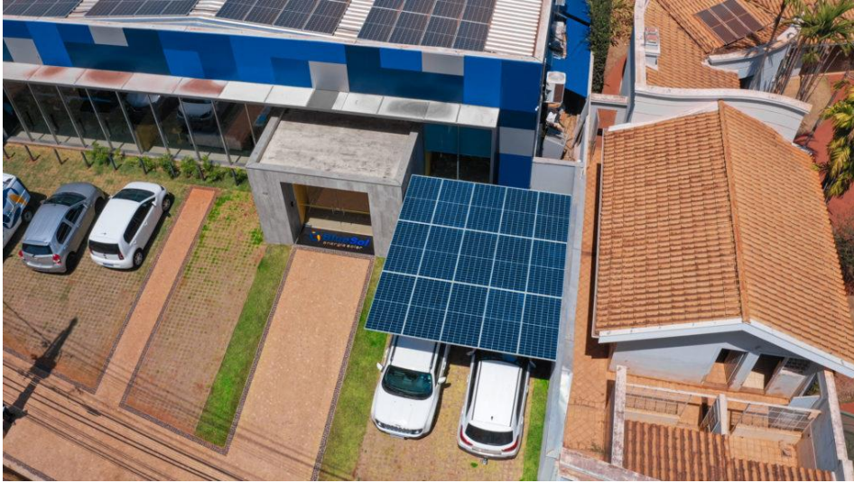
Figura 14 - Estrutura Carport instalado em Ribeirão Preto - SP.
