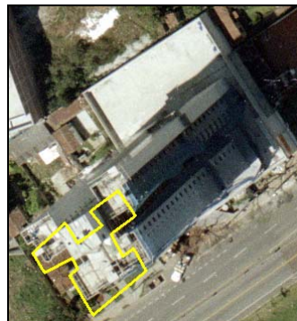
Figura 36: Projeção na imagem aérea do contorno obtido a partir do MDE/laser representado o telhado do edifício avaliado no experimento 2.
