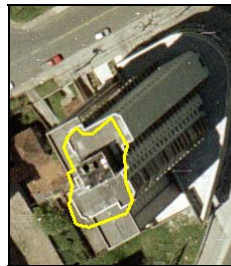
Figura 35: Projeção na imagem aérea do contorno obtido a partir do MDE/laser representado o telhado do edifício avaliado no experimento 1.
