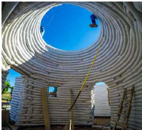
Figura 81: Construção do Centro Infantil Langbos, na África do Sul, utilizando o Superadobe.
