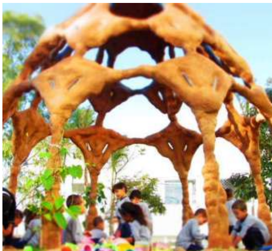
Figura 83: Cobertura feita com estrutura de ferro soldado e revestimento de Calçitice. Projeto para o Centro de Educação Infantil Santo Antônio, em Bauru, contou com a participação de Eliane Amaro.
