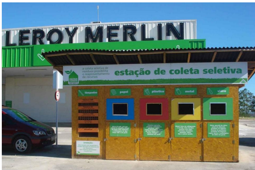
Figura 08 - Estação de coleta seletiva instalada em loja de materiais para construção - Benefício Social
