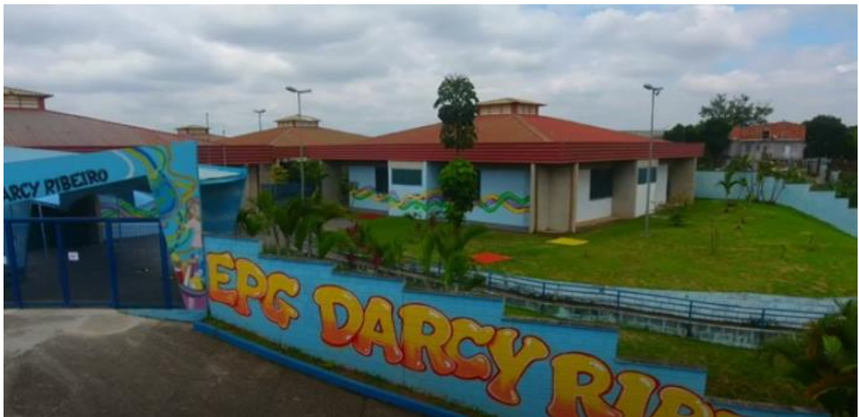
Figura 14 – Vista panorâmica I da EPG Darcy Ribeiro
