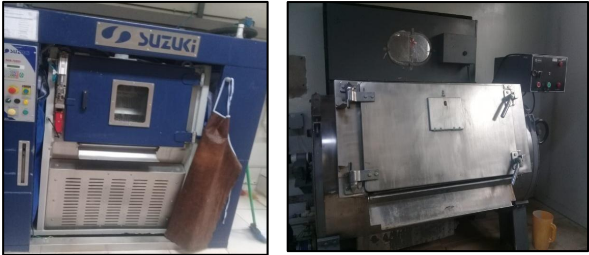
Figura 25 - Lavadora Extratora Suzuki (esquerda) e lavadora Industrial (direita) da Santa Casa de Misericórdia de Fernandópolis.
