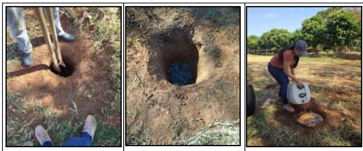
Figura 33 - Teste de infiltração 2 na Santa Casa de Misericórdia de Fernandópolis
