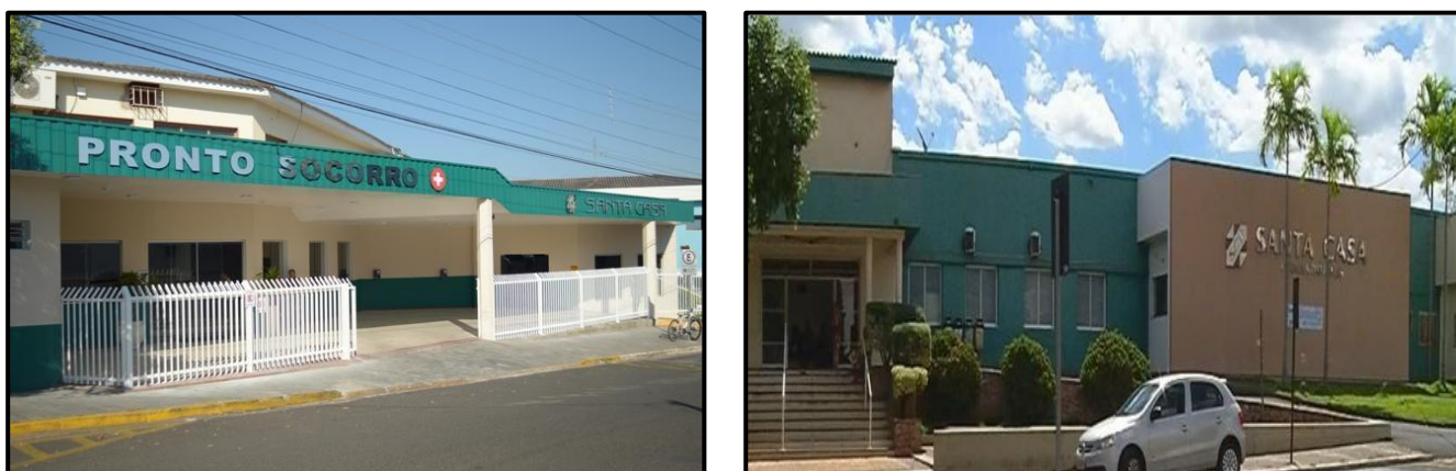
Figura 20 - Entrada para Pronto Socorro (esq.) e Entrada Principal (dir) na Santa Casa de Misericórdia de Fernandópolis.
