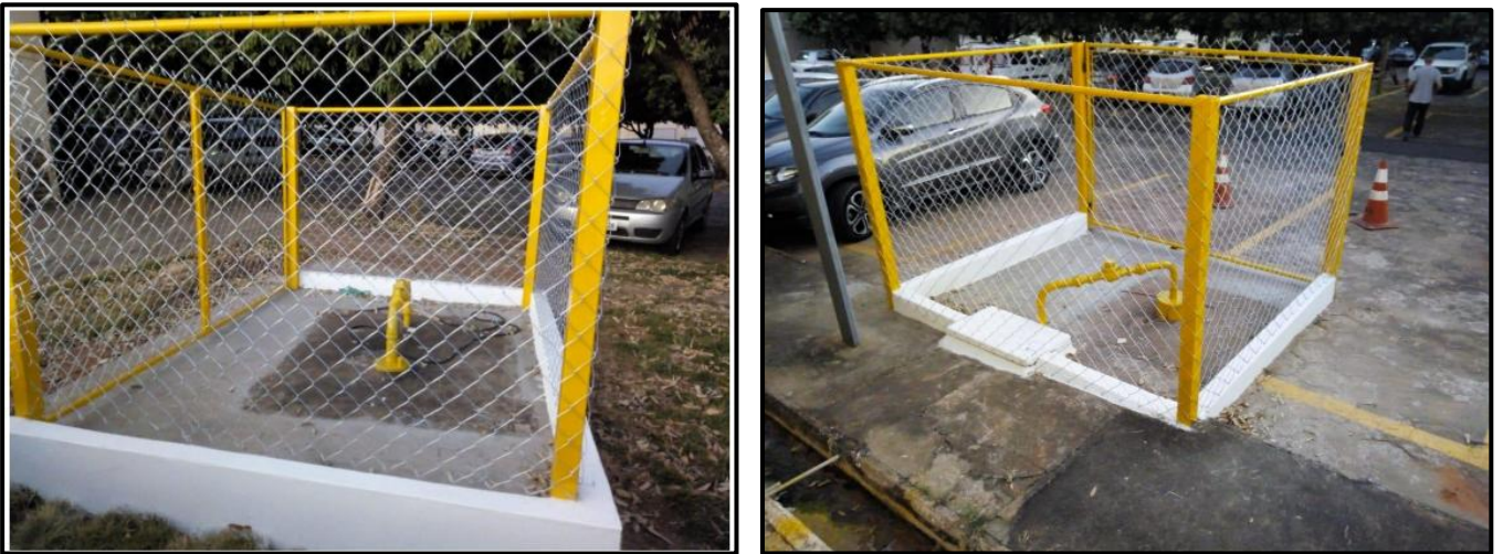
Figura 21 - Poços 1 e 2 da Santa Casa de Misericórdia de Fernandópolis.
