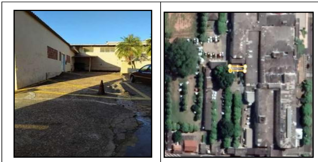
Figura 38 – Vista aérea, frontal da área de instalação (55 m 2 ) do sistema de tratamento na Santa Casa de Misericórdia de Fernandópolis
