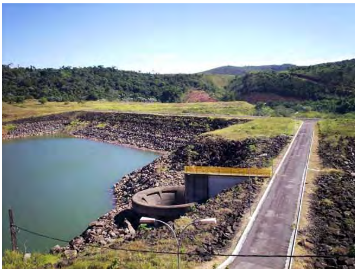
Foto 34: Barramento e vertedouro da Represa de Chapéu D'Uvas (06/02/2010).
