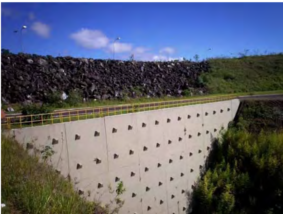
Foto 35: Barragem de Chapéu D'Uvas (06/02/2010).
