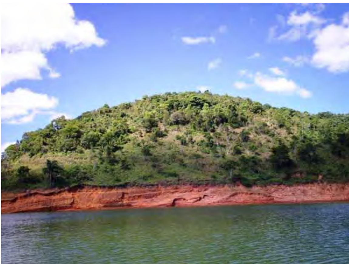
Foto 28: Processo erosivo nas margens da Represa de Chapéu D'Uvas (07/08/2011).
