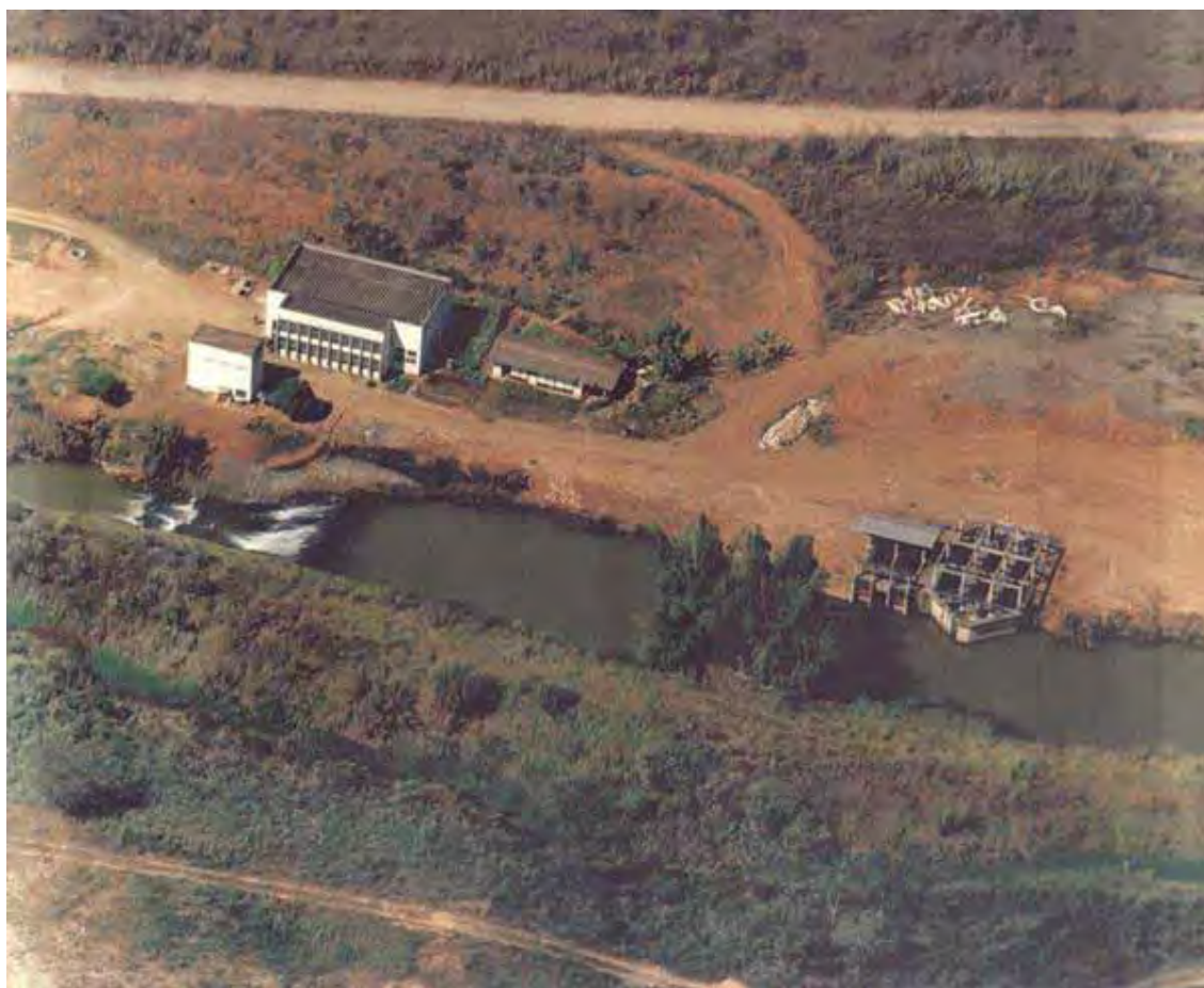
Foto 38: Captação de água no Ribeirão do Espírito Santo.
