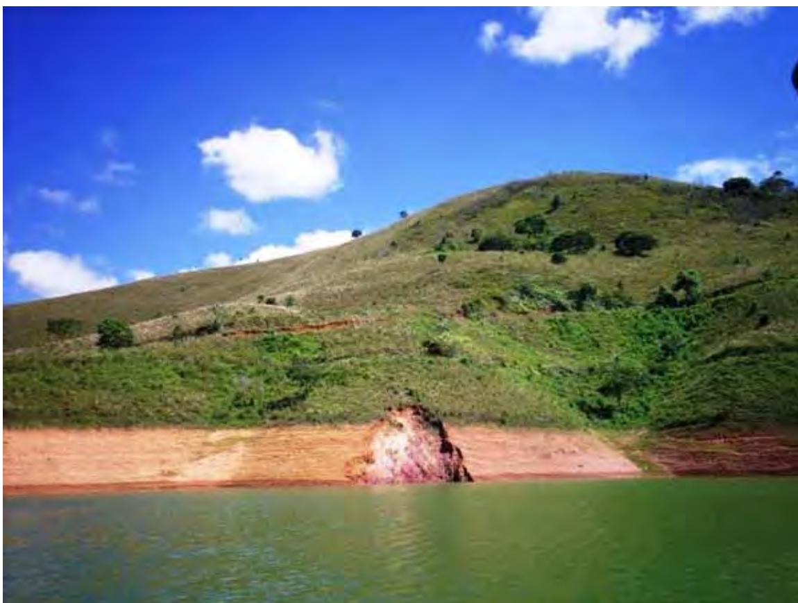
Foto 27: Processo erosivo nas margens da Represa de Chapéu D'Uvas (06/02/2010).
