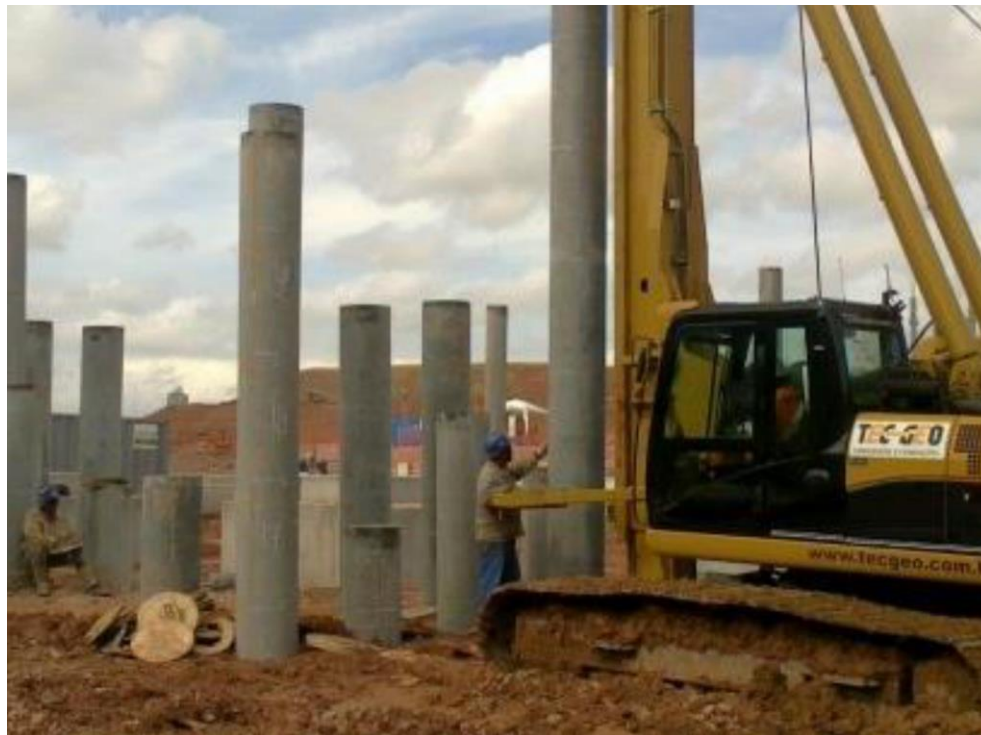
Figura 7. Fundação profunda (estaca).
