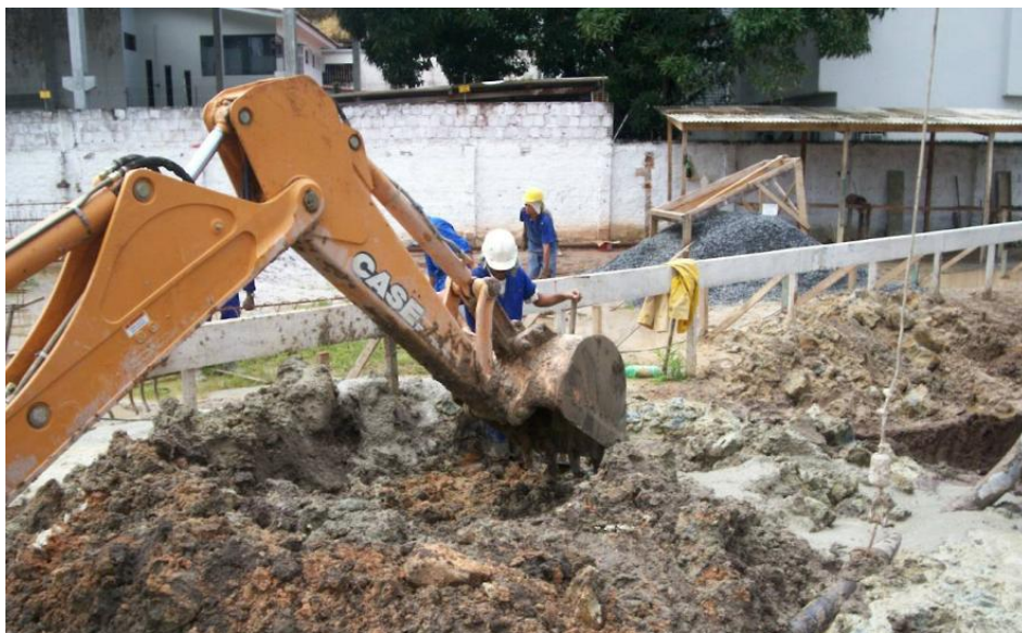
Figura 15. Limpeza do terreno com retroscavadeira após a concretagem da estaca.
