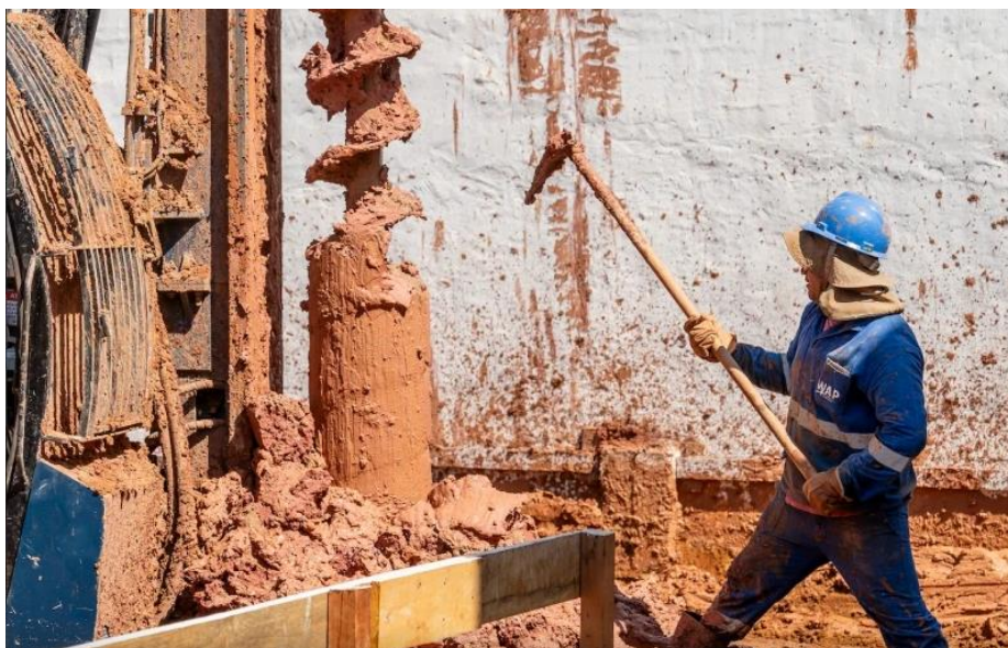
Figura 11. Perfuração da estaca hélice contínua.
