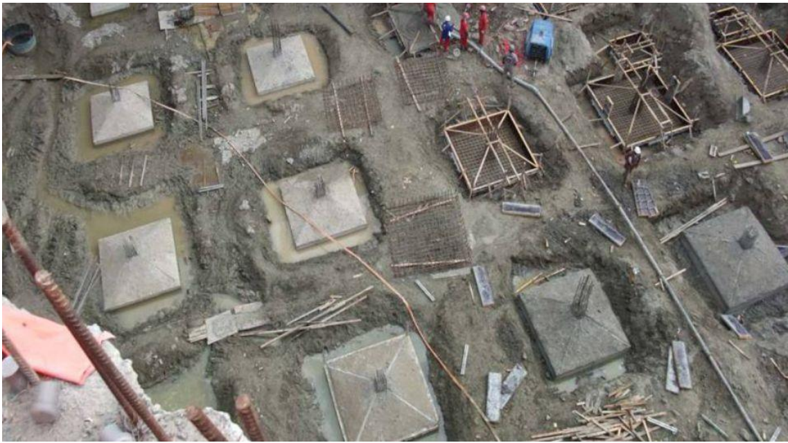
Figura 4. Fundação rasa (sapata).
