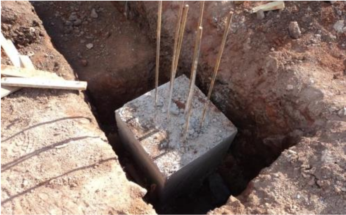
Figura 2. Fundação rasa (bloco).
