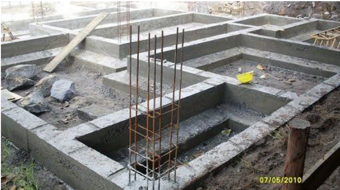
Figura 3. Fundação rasa (sapata corrida).
