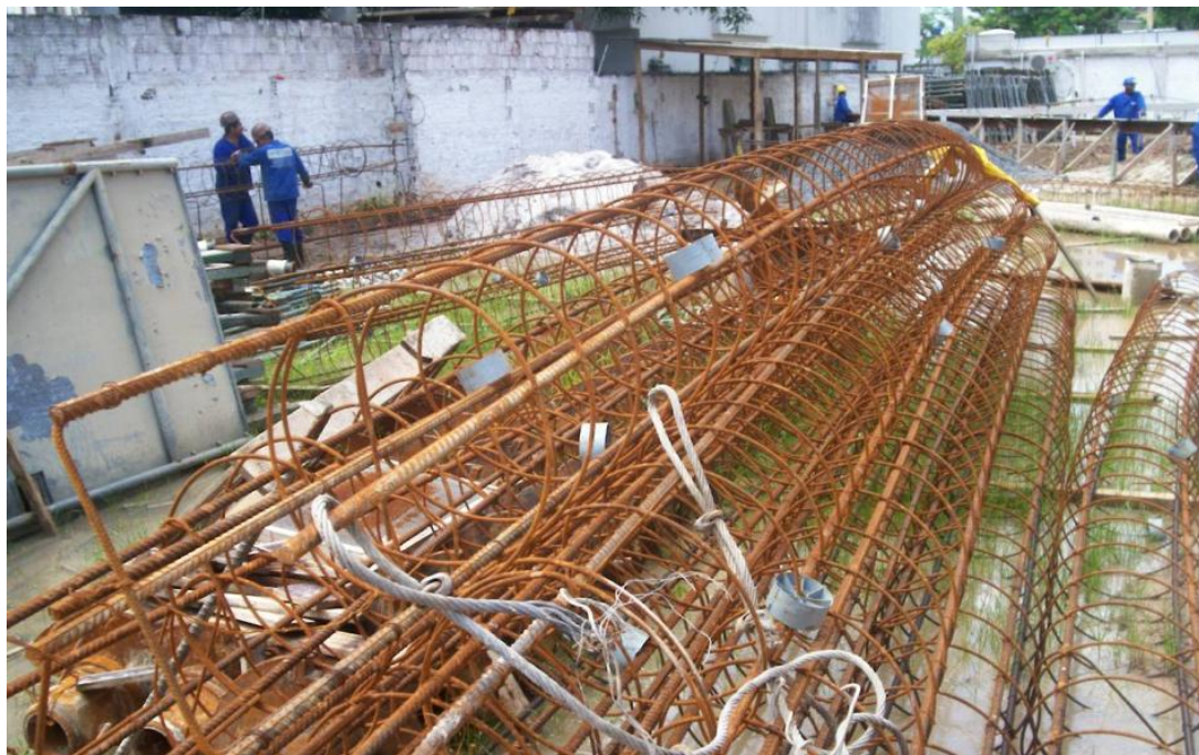
Figura 17. Armadura de estaca hélice contínua com espaçadores plásticos.
