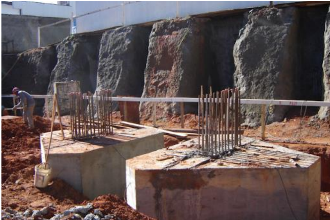
Figura 1. Estrutura de fundação.
