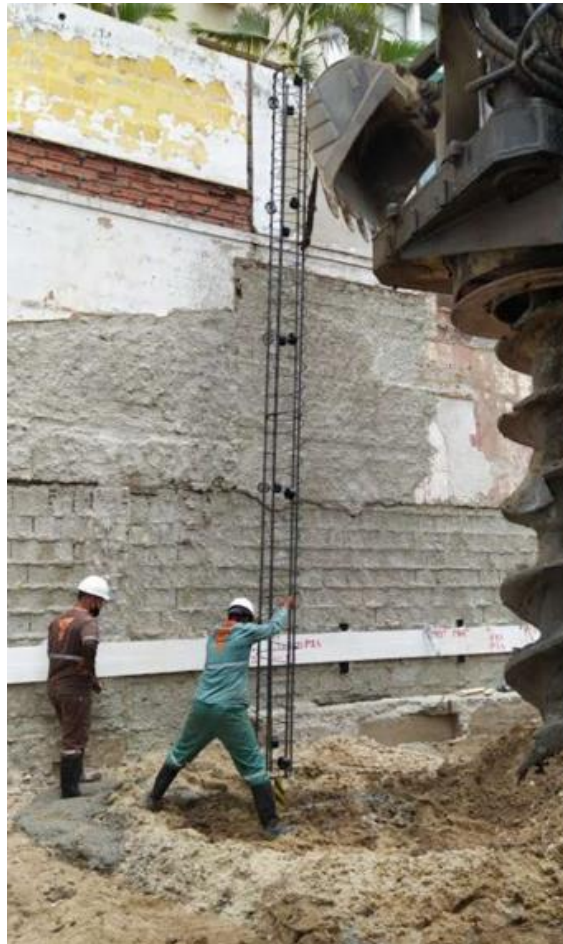
Figura 16. Armadura de estaca hélice contínua com espaçadores plásticos.
