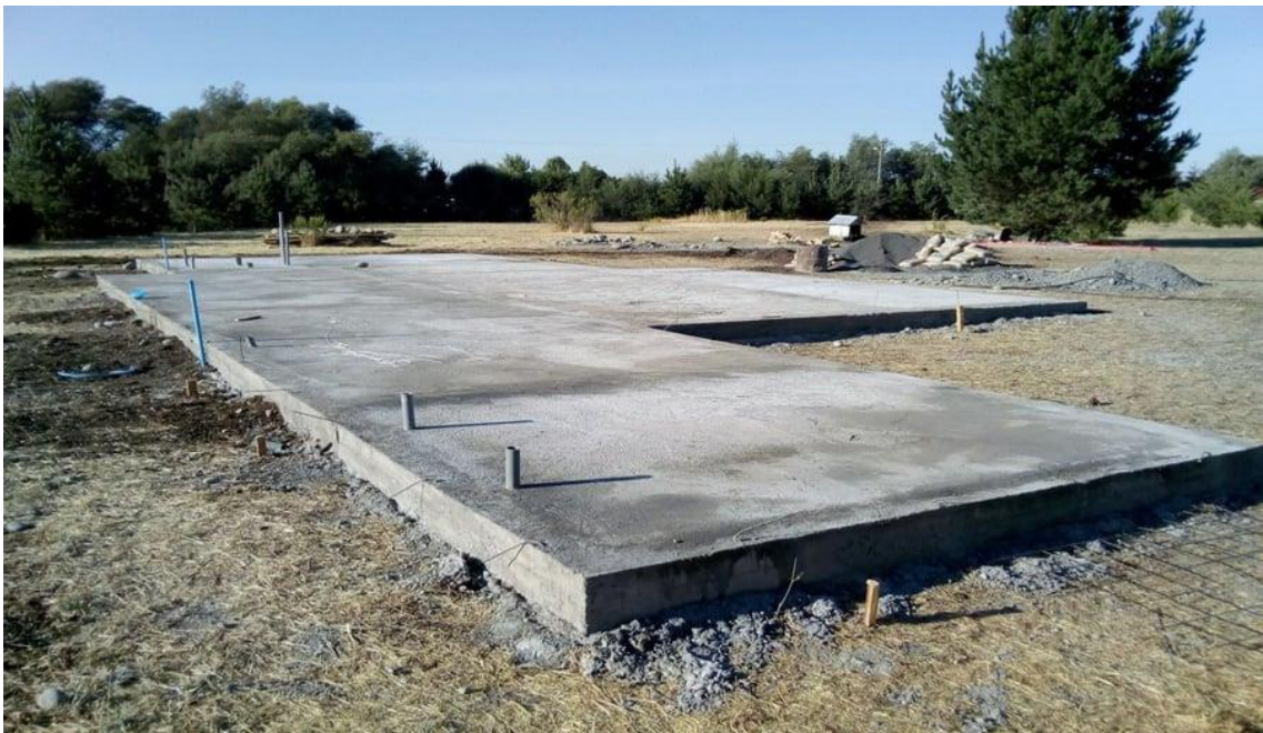
Figura 5. Fundação rasa ( radier ).
