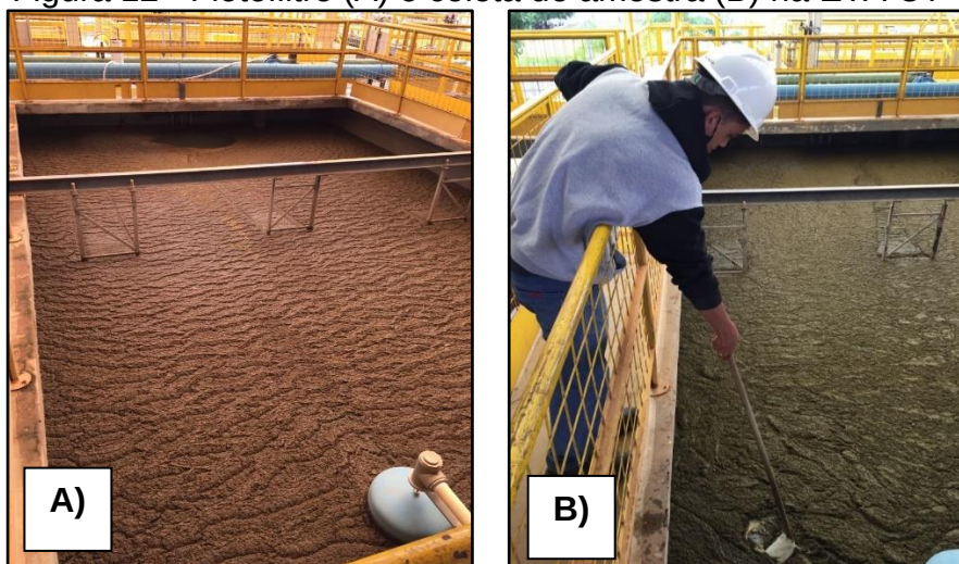
Figura 12 - Flotofiltro (A) e coleta de amostra (B) na ETA CT
