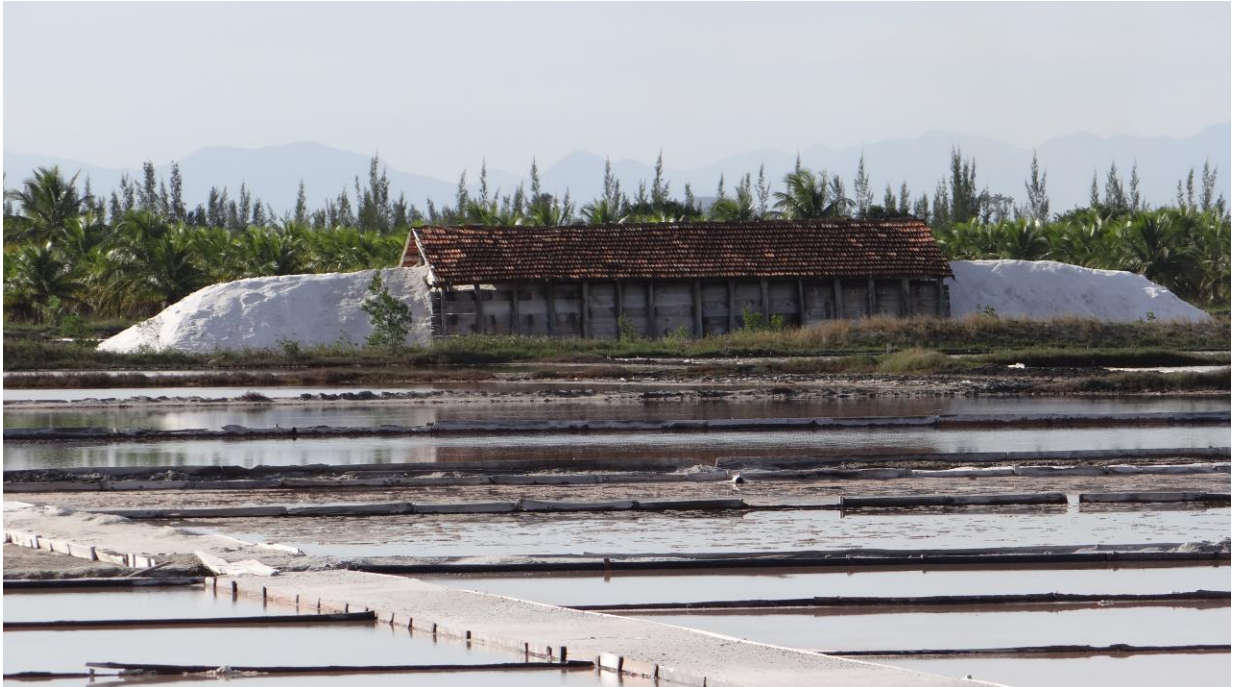
Figura 46 – Vista dos galpões da salina Fluminense, Praia Seca, Araruama/RJ (2014) Fotografia : Serjão Augusto Acervo pessoal
