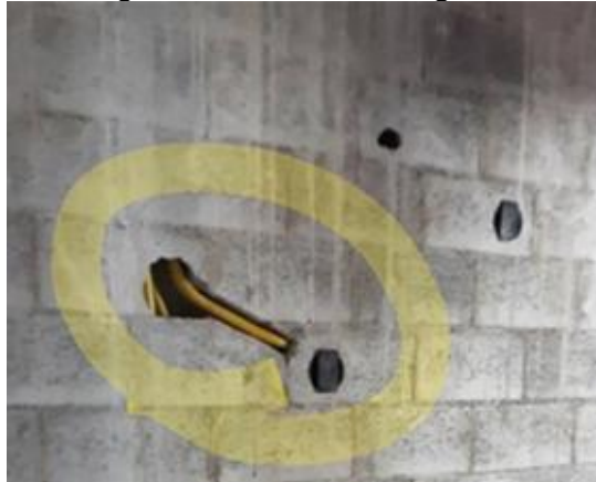
Figura 38 - Blocos rasgados
