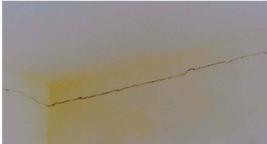
Figura 28 - Formas horizontal devida movimentação térmica da laje.
