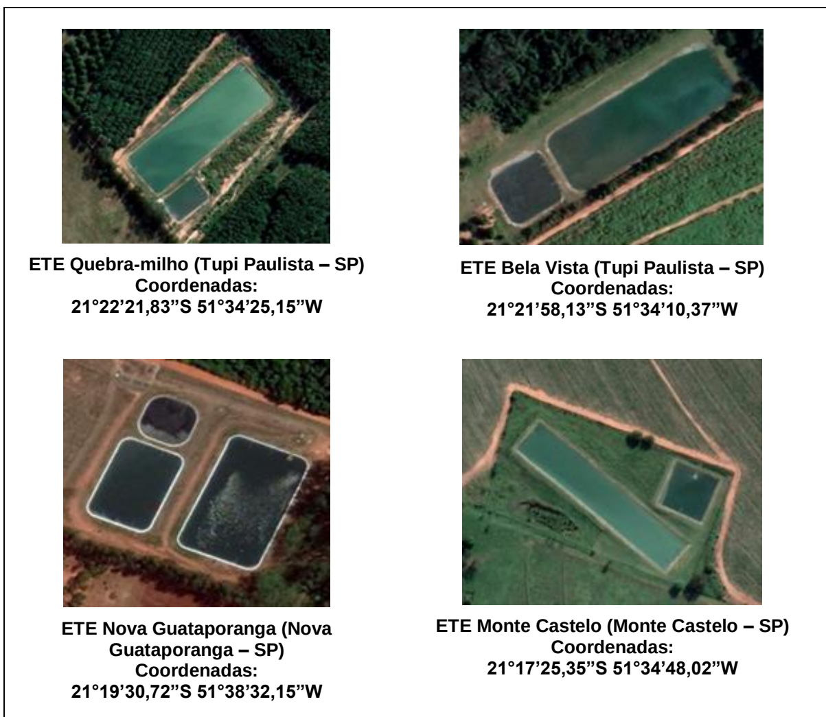
Figura 6 – Estações de Tratamento de Esgoto localizadas na microbacia hidrográfica do córrego do Galante - SP
